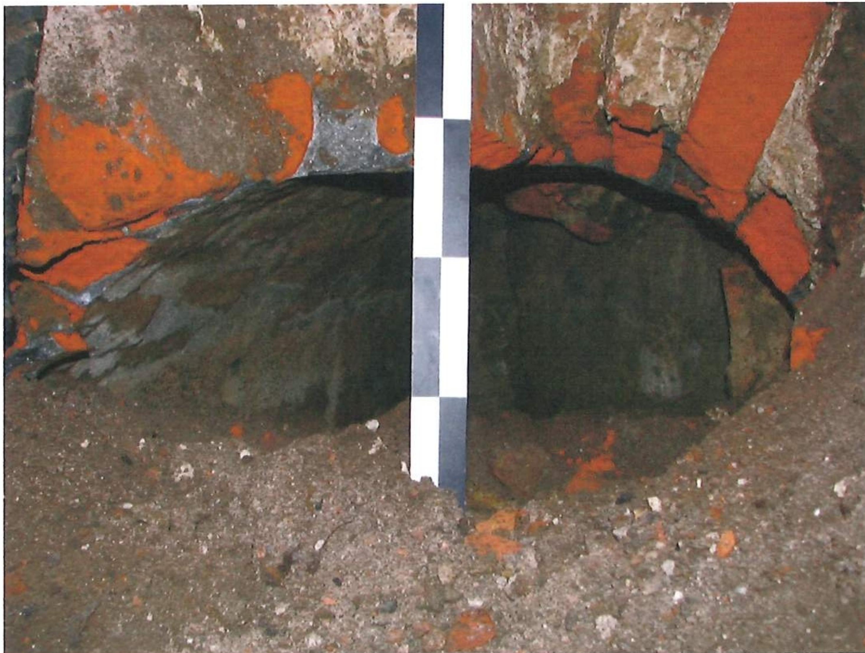
Fot. 12a sklepienie piwniczki widoczne w wykopie II, na wysokości przepompowni.
