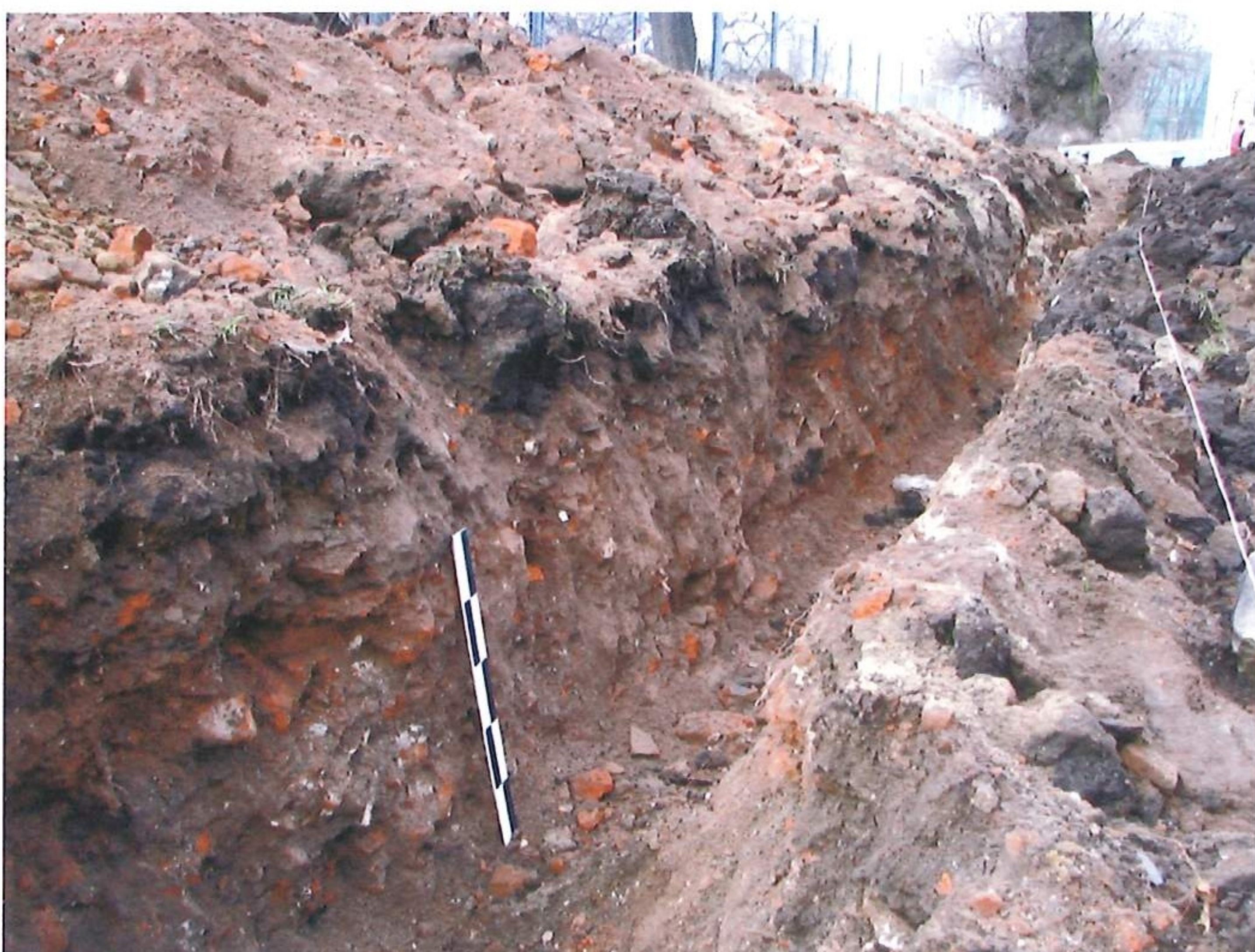
Fot. 44. Wykop VIII, pod kabel światłowodowy a odcinku do 25 metra od kładki przez łąkę.
