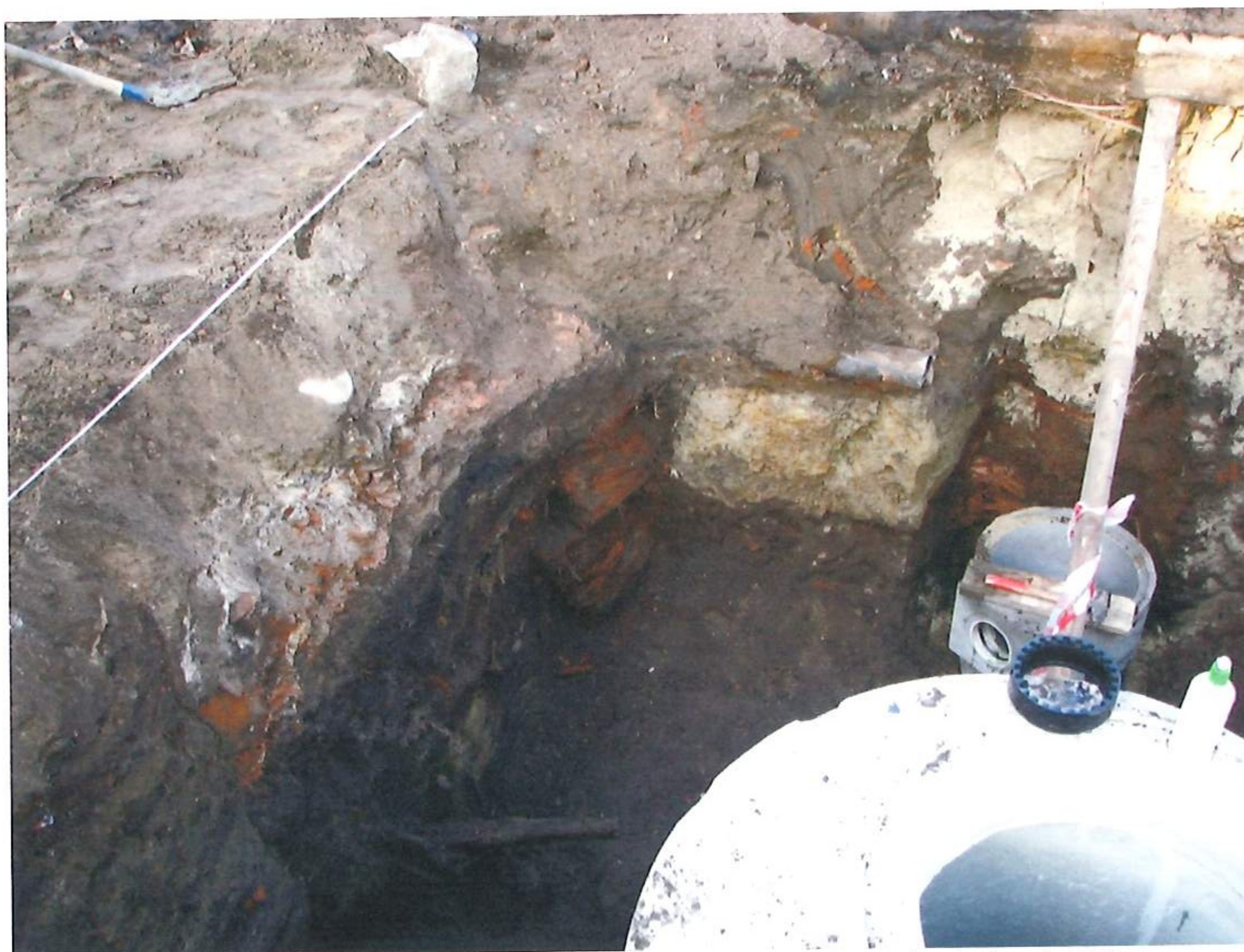
Fot. 24. Wykop IV przy studzience SD 1 (odcinek II)
