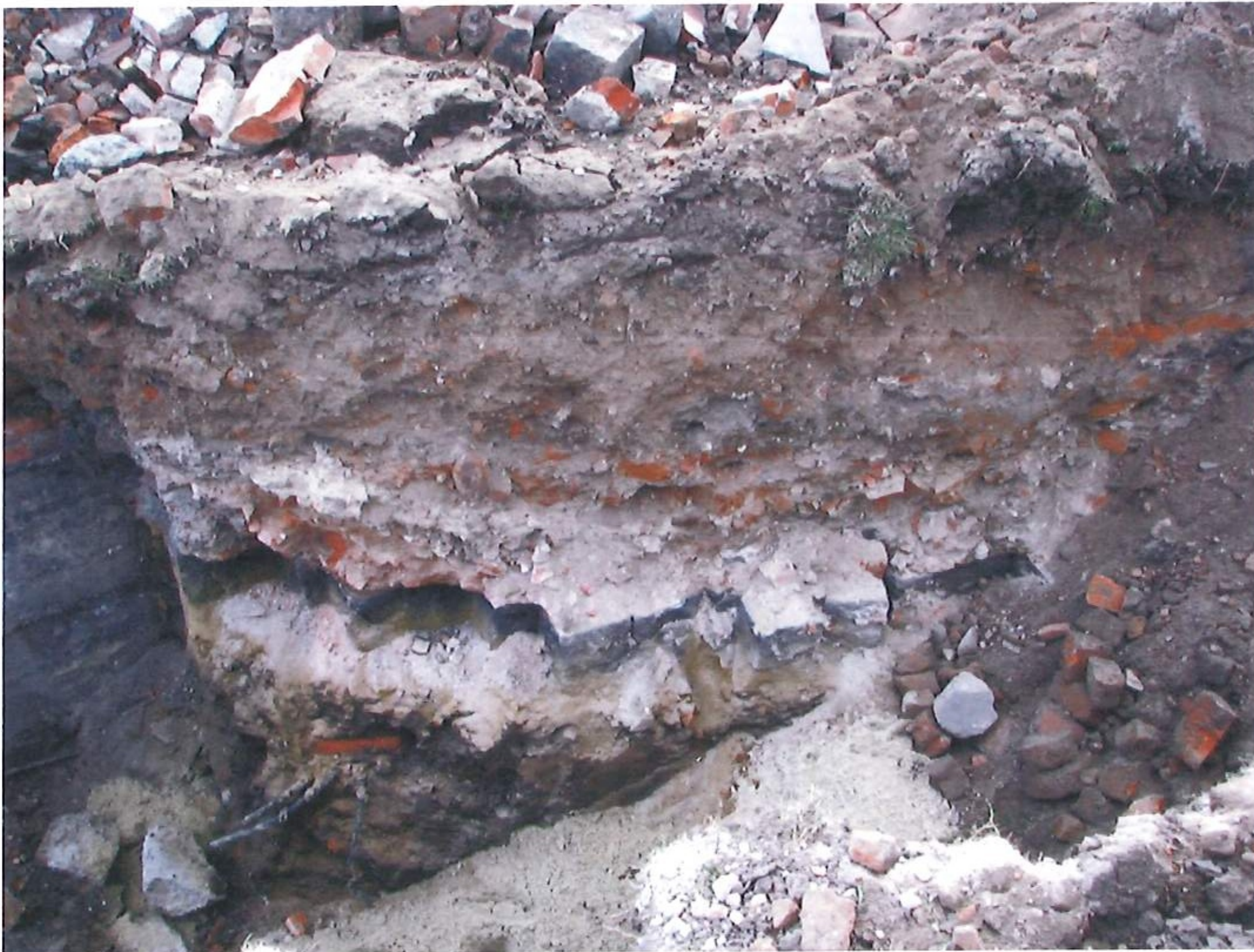
Fot. 07. Wykop II, profil S na wysokości 15 metra od studzienki SD4.
