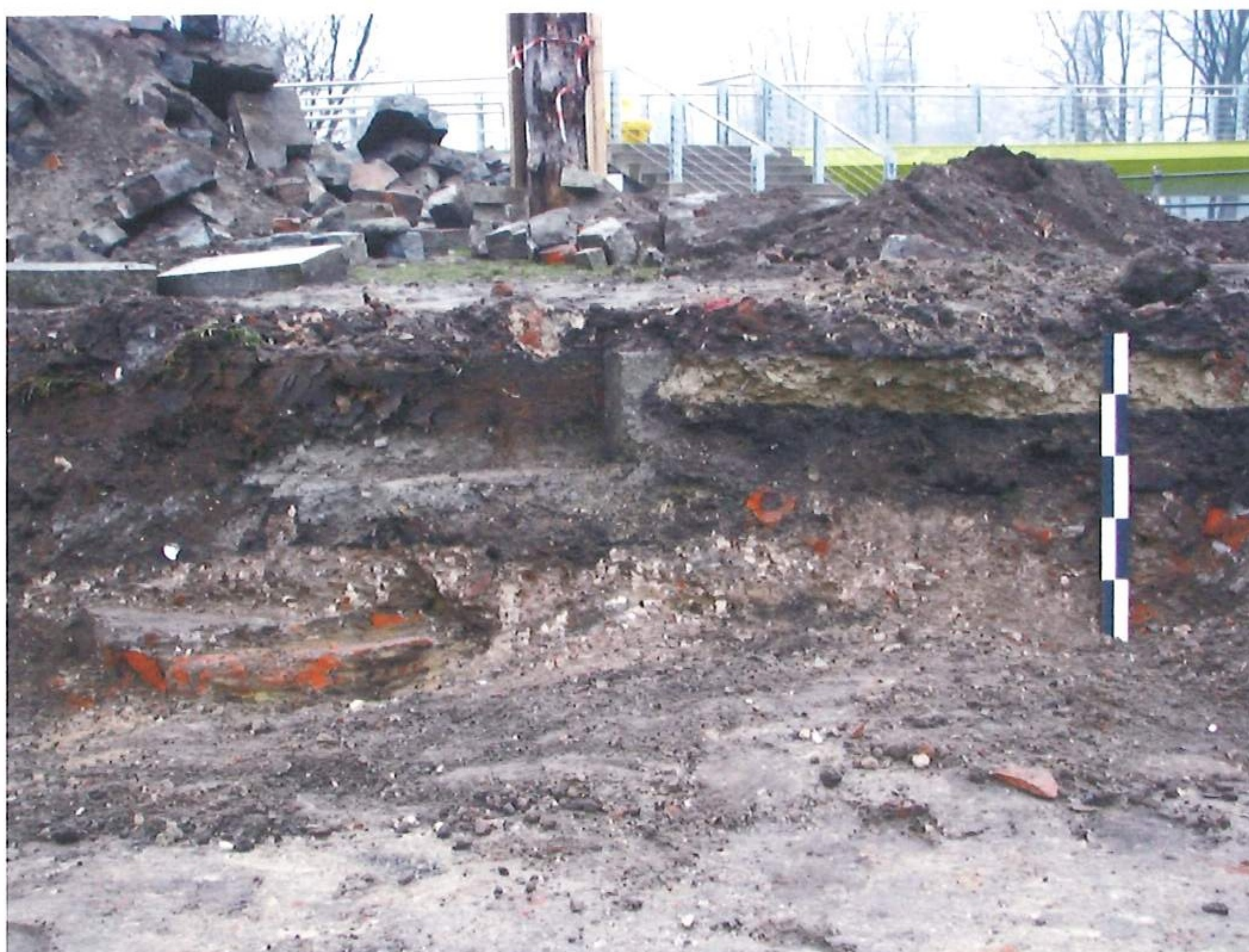
Fot. 35. Wykop V, profil NW.
