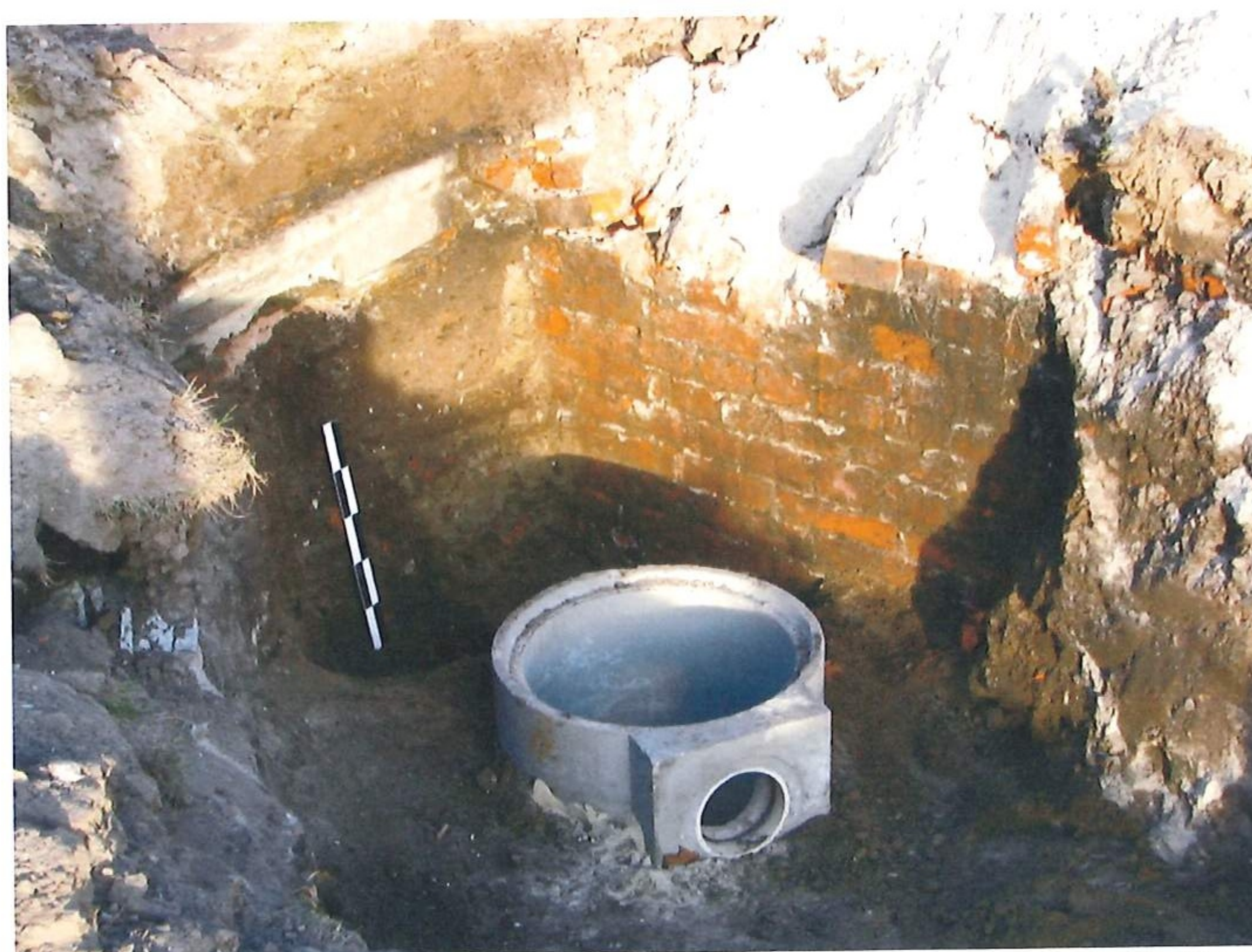
Fot.04. wykop I profil N wraz z fragmentem ceglanego muru.
