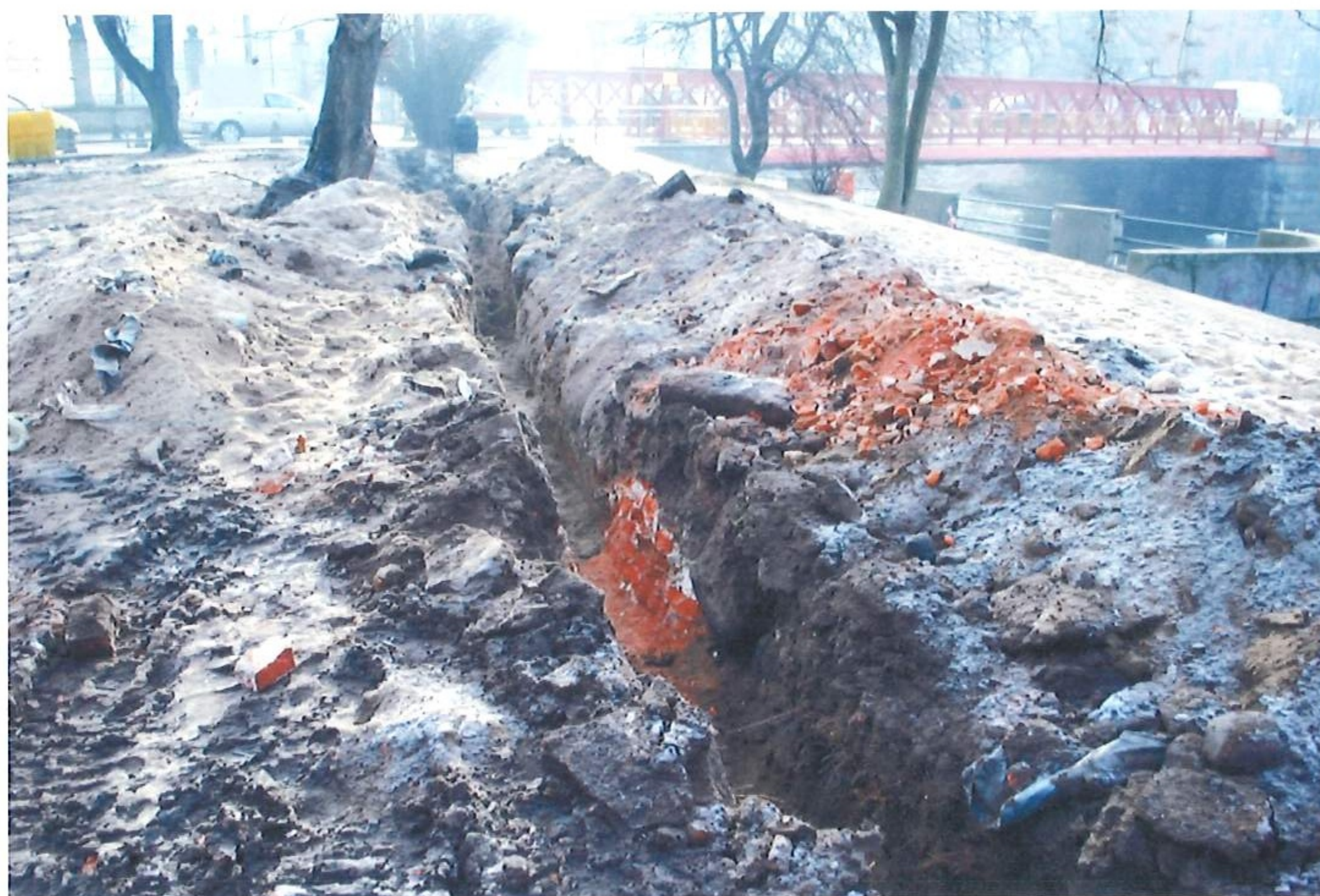
Fot. 46c. Wykop VIII a wzdłuż zachodniej krawędzi wyspy, po wschodniej stronie ciągu pieszego.
