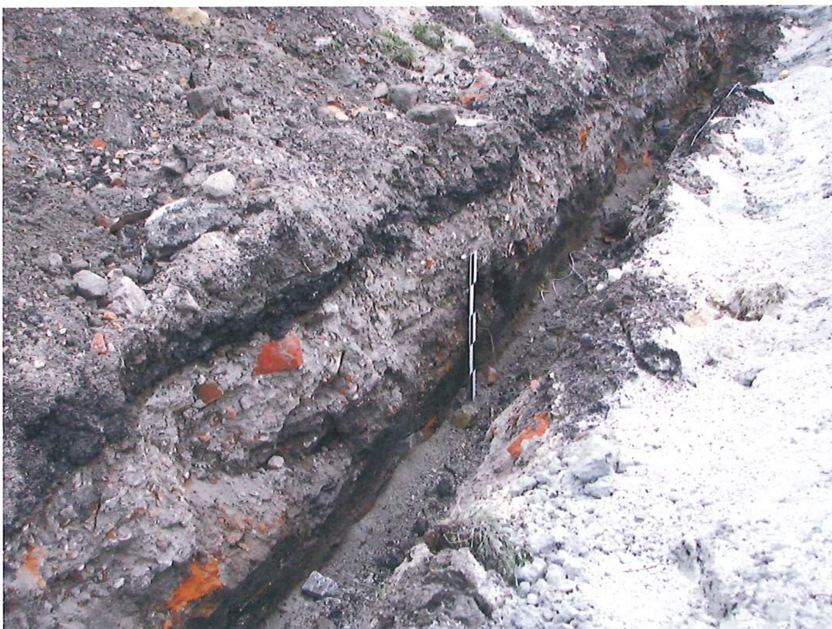
Fot. 46. Wykop VIII pod kabel światłowodowy na odcinku od 25 do 55 metra od kładki przez śluzę
