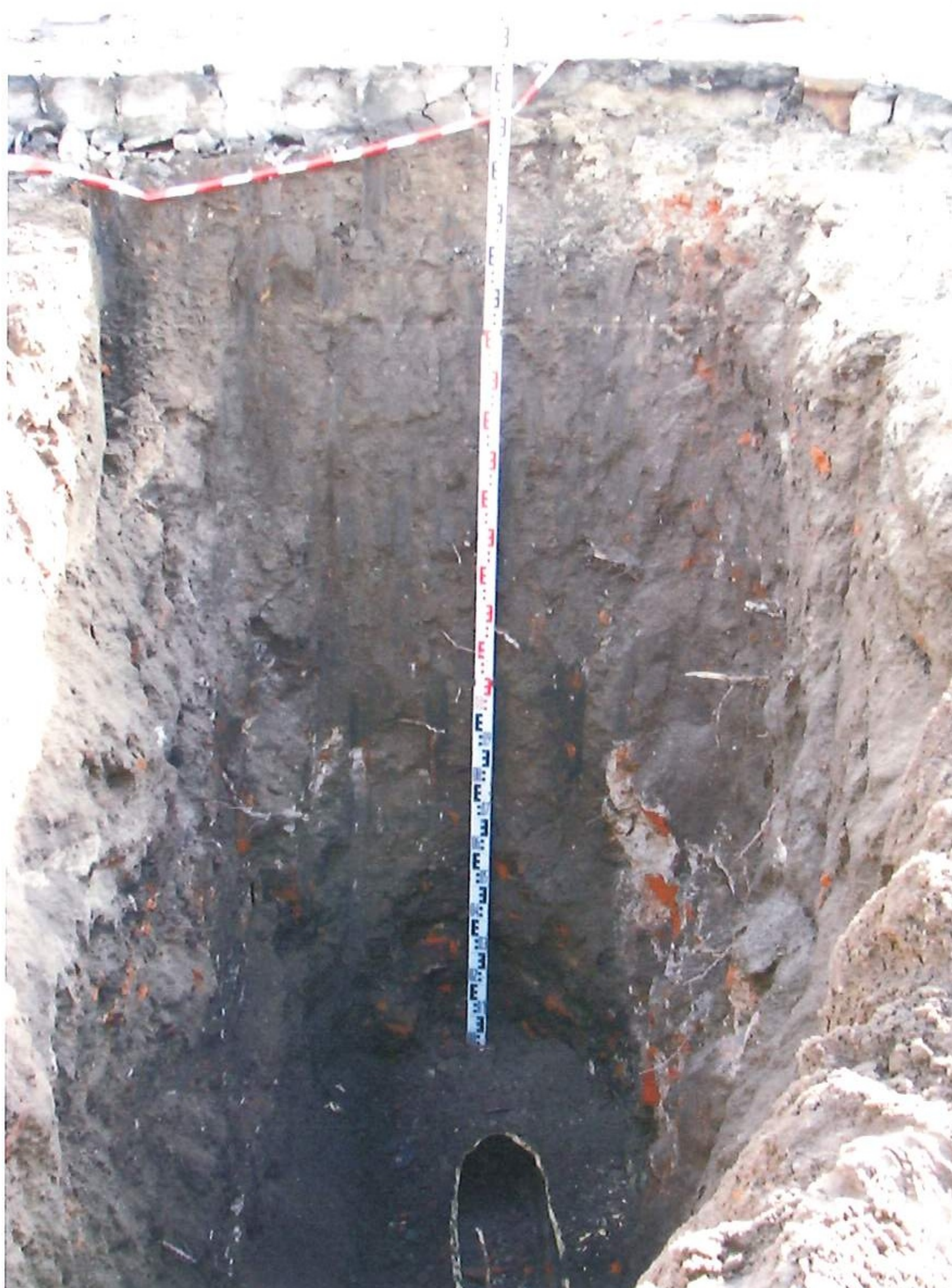
Fot. 29a. Wykop IV, odcinek I, profil SE.
