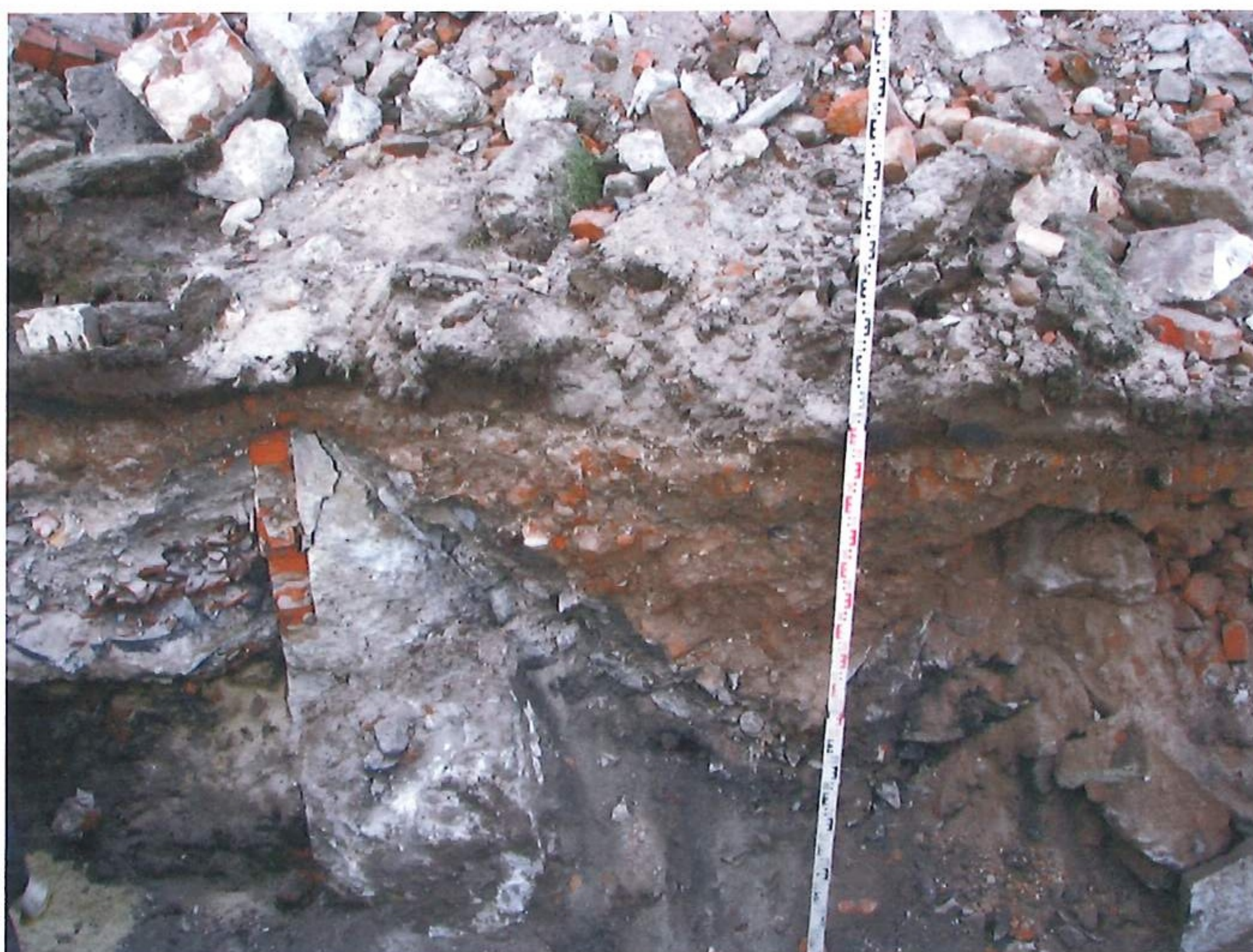
Fot. 11. Wykop II, profil N na wysokości 18 metra od studzienki SD4.
