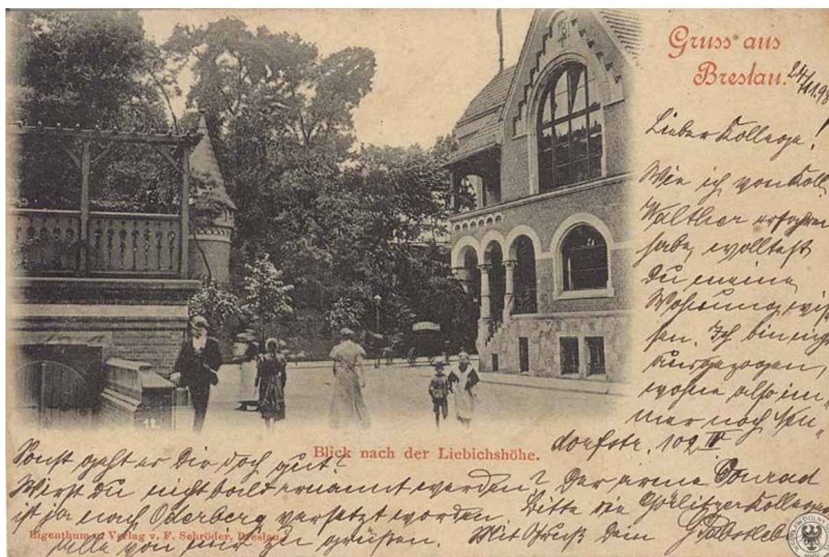
Ryc. 76. Pocztówka przedstawiająca fragment zabudowy przy ul. Nowej z wejściem do kazamat działobitni barkowej oraz budynkiem d. siedziby korporacji studenckiej „Borussia”, w widoku od strony północno-wschodniej; datowanie: 24.11.1898 r. [między 1896 a 1898 r.]. Wg: https://polska-org.pl/858858,foto.html?idEntity=586813 (data dostępu 15.12.2022).
