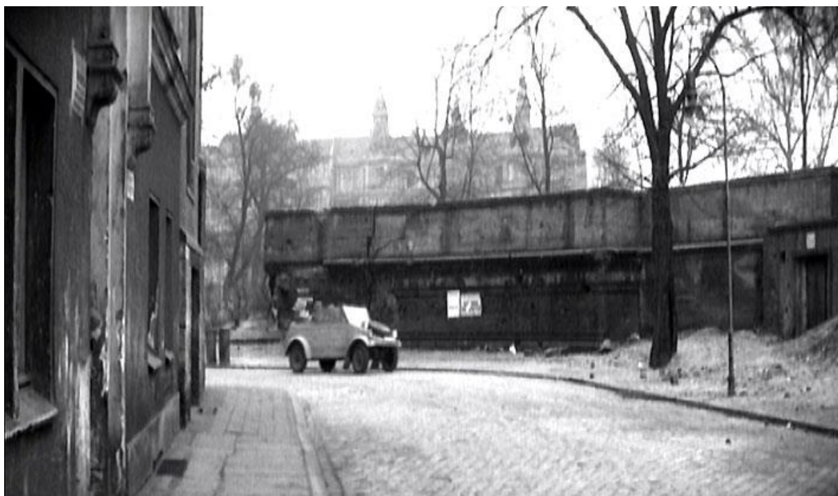
Ryc. 110. Fotografia (kadr filmowy) z przedstawieniem wnętrza urbanistycznego południowej części ul. Nowej we Wrocławiu z bunkrem na tylnym planie, w widoku od strony zachodniej; opis na stronie internetowej: Ulica Nowa w scenie z „Giuseppe w Warszawie” , datowanie: 1964 r. (wg: polska-org.pl). Wg: https://polska-org.pl/843509,foto.html?idEntity=586813 (data dostępu: 15.12.2022)
