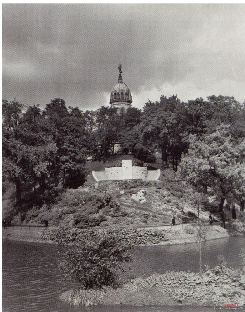
Ryc. 93. Fotografia przedstawiająca ob. Wzgórze Partyzantów (strefę dawnego narożnika bastionu) w widoku od strony południowo-wschodniej zza Fosy Miejskiej (z kamienicy przy ul. Podwale), po wzniesieniu Pomnika Kolonii Niemeickich, przed założeniem ogrodu różanego; datowanie: „1932” (wg: www.herder-institut.de); w zbiorach Herder-Institut w Marburgu, zespół: Poklekowski, sygn. BAG_2010. Wg: https://fotopolska.eu/727363,foto.html?o=b8909 (data dostępu: 6.12.2022)
