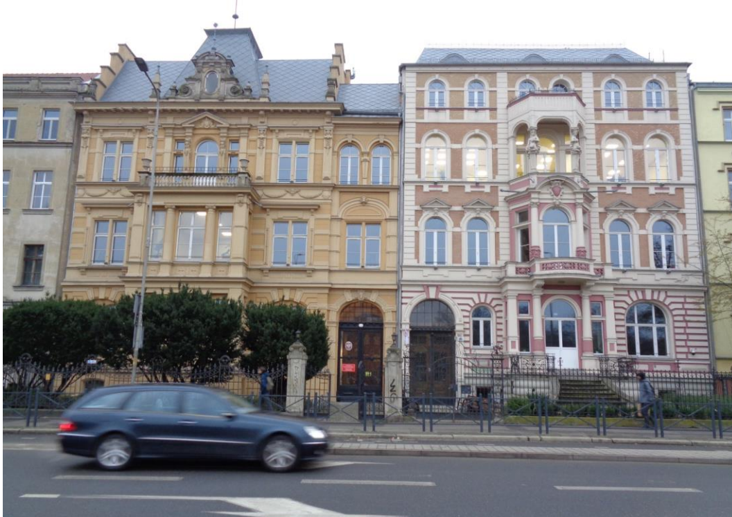
Ryc. 238. Wrocław, rejon Wzgórza Partyzantów, zabudowa przy ul. Podwale stanowiąca zamknięcie historycznej („pofortecznej”) osi kompozycyjnej generowanej przez narożnik Wzgórza (dawnenaroże Bastionu Sakwowego). Fot. A. Kwaśniewski, 5.12.2022.
