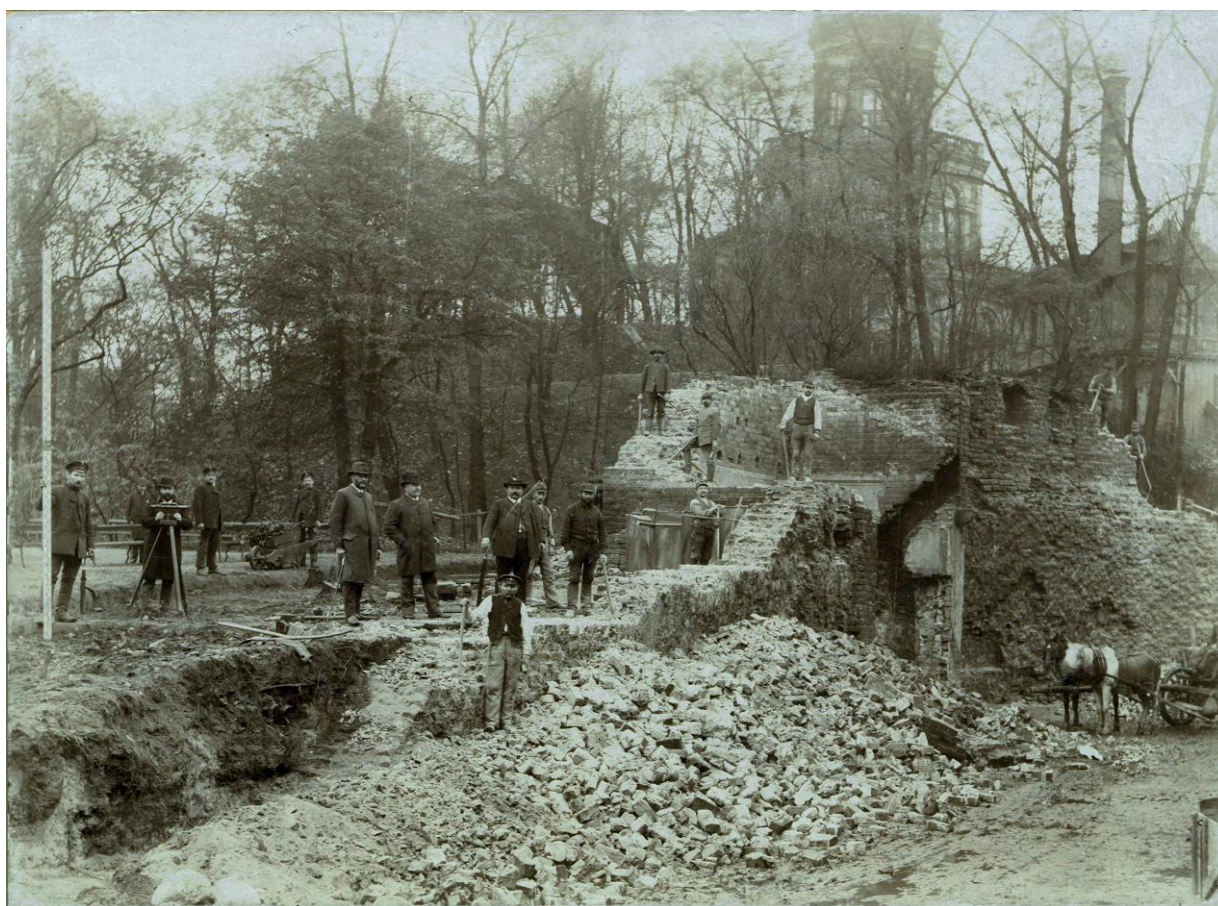
Ryc. 70. Fotografia przedstawiająca burzenie baszty i murów obronnych w miejscu obecnego południowego odcinka ul. Nowej we Wrocławiu, w widoku od strony północnej (z ob. Wzgierzem Partyzantów na tylnym planie); datowanie: „1895”; skan fotografii w zasobach Biblioteki Cyfrowej Uniwersytetu Wrocławskiego: https://www.bibliotekacyfrowa.pl/dlibra/publication/20657/edition/28871/content (data dostępu: 24.11.2022). Wg: https://polska-org.pl/771917,foto.html?idEntity=508918 (data dostępu: 24.11.2022)
