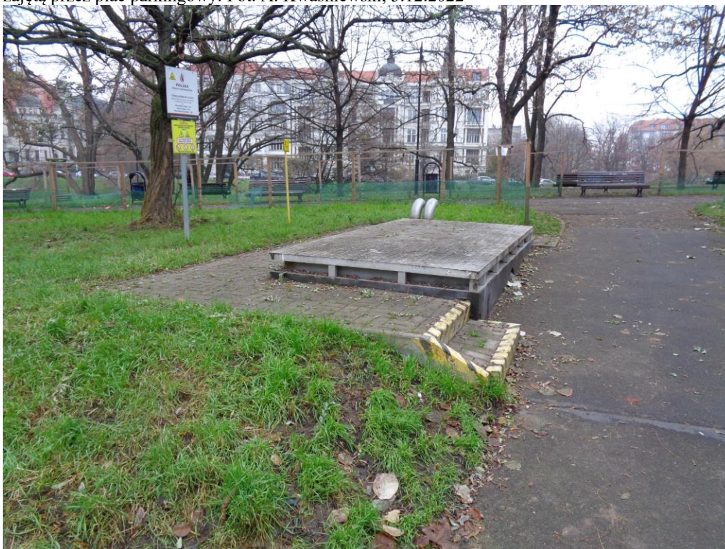
Ryc. 246. Wrocław, Wzgórze Partyzantów, współczesna podziemna infrastruktura techniczna w południowej partii zielenca przy ul. Nowej, w miejscu historycznego budynku toalet. Fot. A. Kwaśniewski, 5.12.2022
