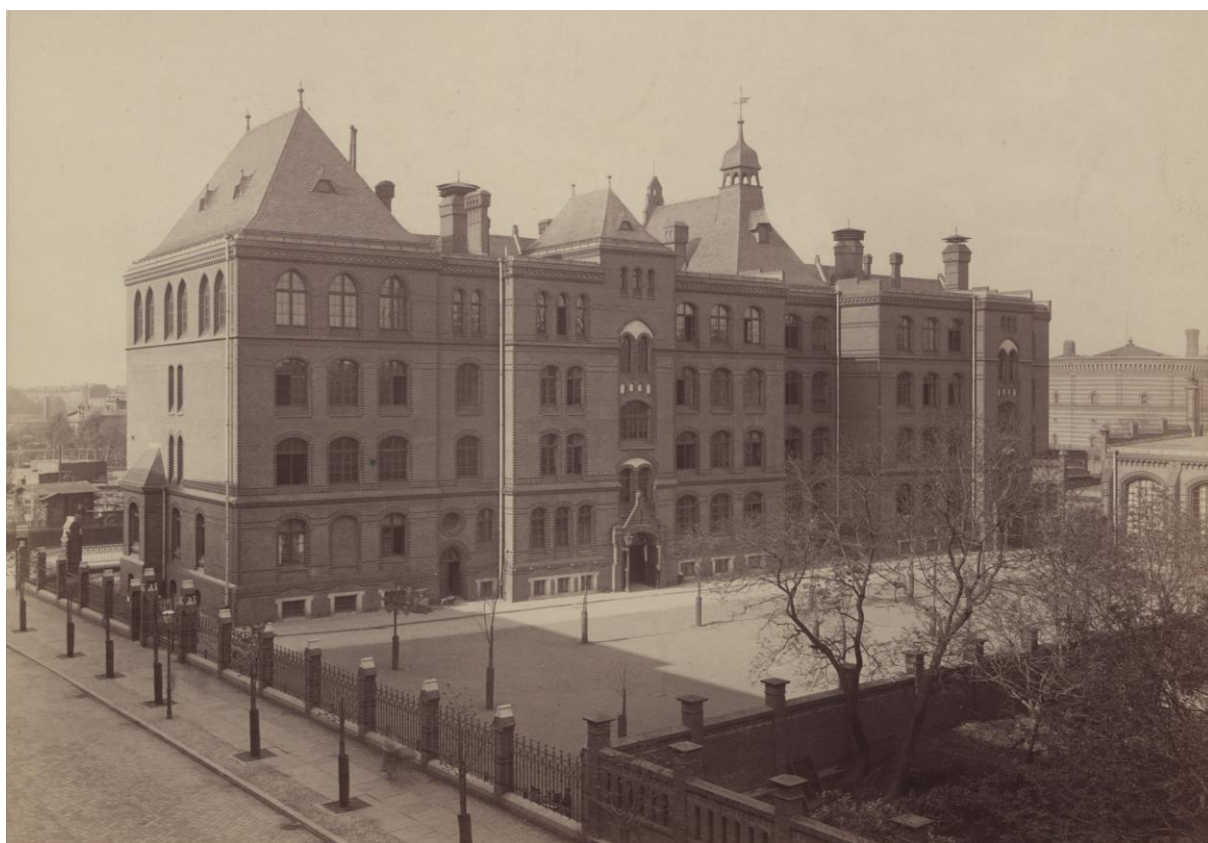
Il. 10. Szkoła Ludowa przy ul. Tęczowej 60, widok pn.-zach. narożnika ogrodu domu opieki Trójcy Świętej. Fot. Ed. van Delden, ok. 1895 r.
