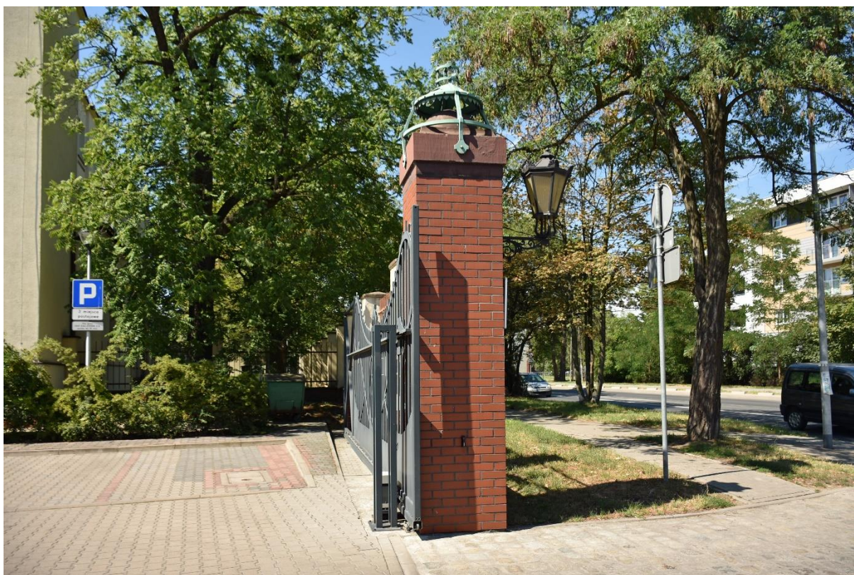
Fot. 58 Gazownia Miejska Wrocław-Tarnogaj, brama prowadząca na teren PSG Sp. z o.o., na słupie oryginalna konstrukcja na lampę, widok od wschodu.
