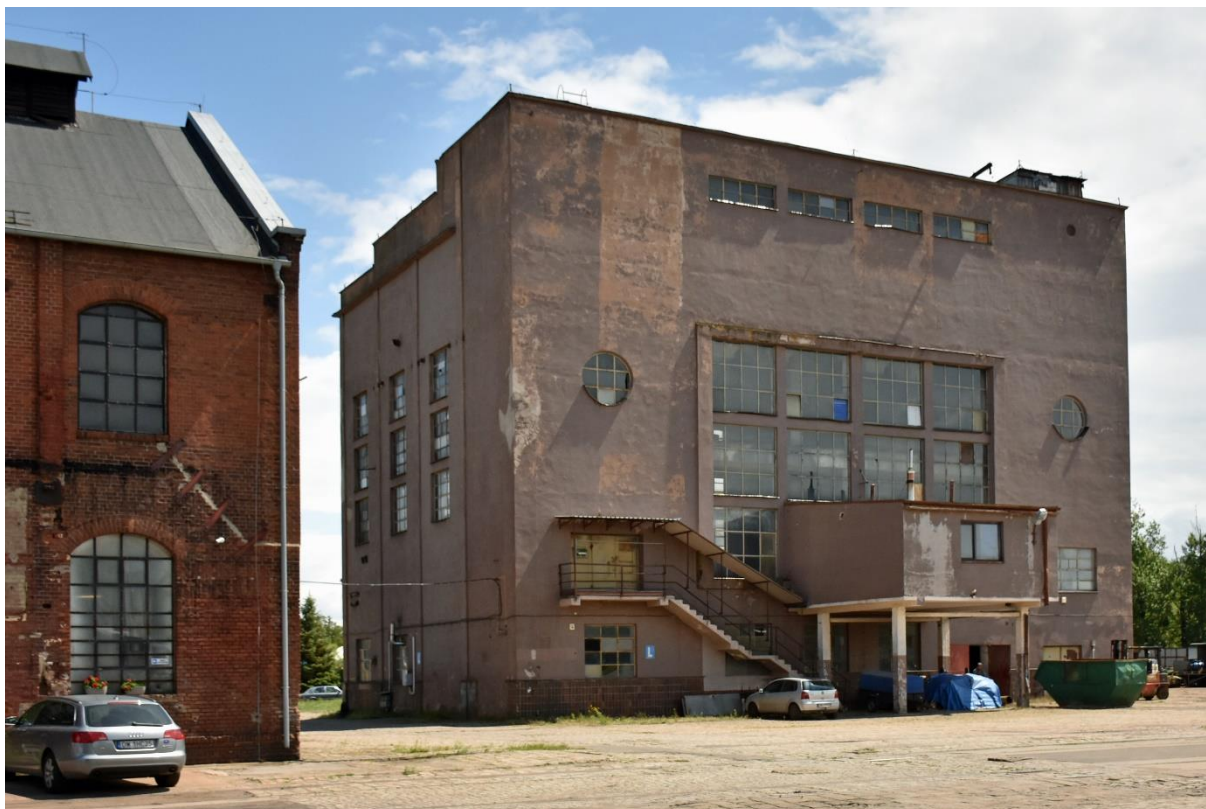
Fot. 37 Gazownia Miejska Wrocław-Tarnogaj, budynek nowej kotłowni z lat. 60. XX w., widok północnego zachodu.
