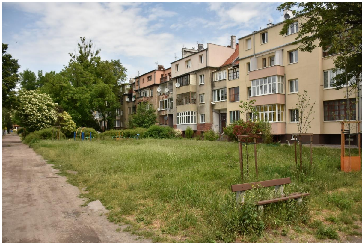
Fot. 5 Ulica Tarnogajska. Widok od południowego zachodu na elewacje tylne od strony podwórza.
