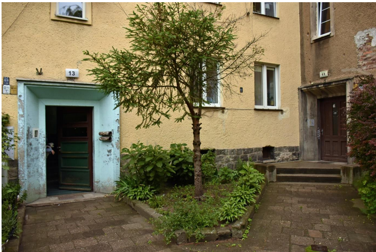
Fot. 77 Wejście do kamienic przy ulicy Henrykowskiej nr 11 i 13.
