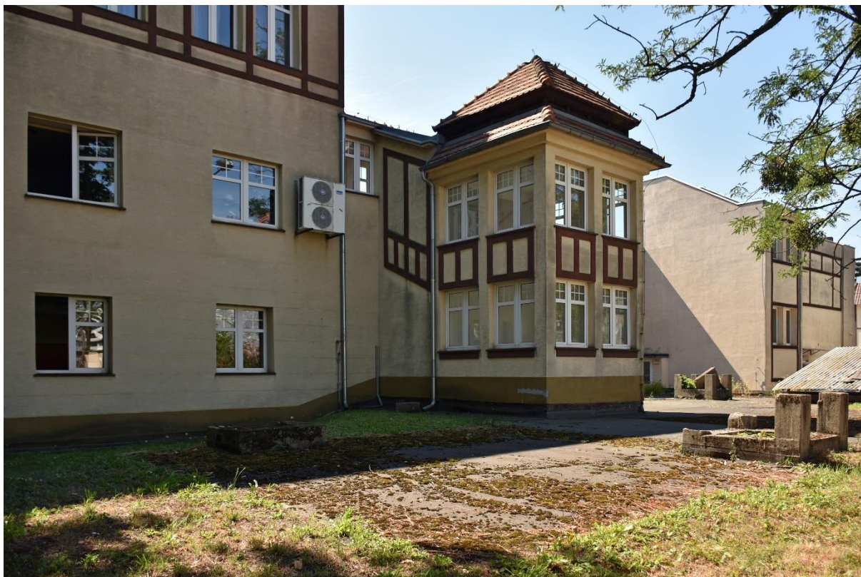
Fot. 51 Gazownia Miejska Wrocław-Tarnogaj, dawny dom pomocy społecznej, widok od północnego wschodu.
