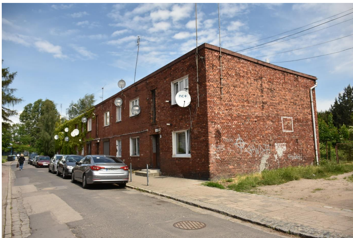
Fot. 16 Ulica Złotostocka. Ciąg budynków mieszkalnych nr 6, 8, 10, 12, widok od południa.
