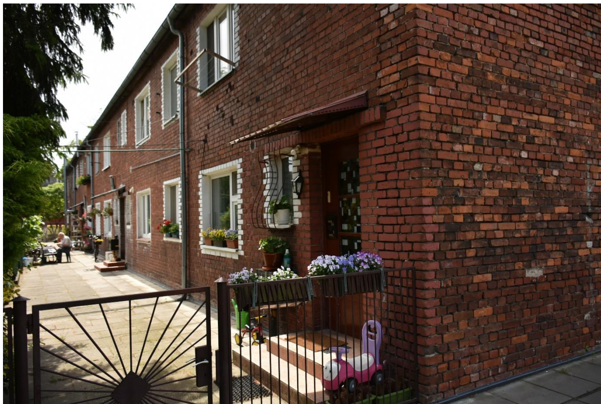
Fot. 19 Ulica Złotostocka. Ciąg budynków mieszkalnych nr 16, 18, 20, 22, widok od północy na elewację tylną.
