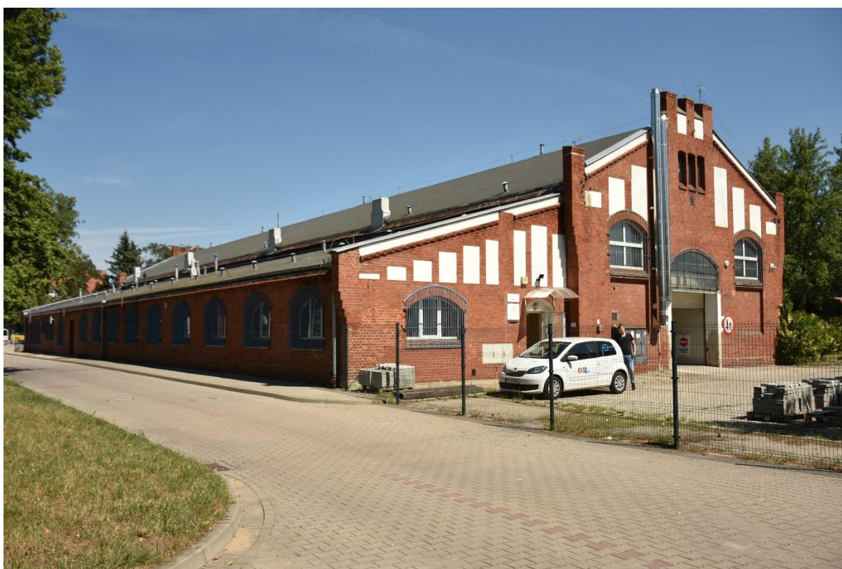
Fot. 54 Gazownia Miejska Wrocław-Tarnogaj, budynek dawnego magazynu, widok od południowego zachodu.
