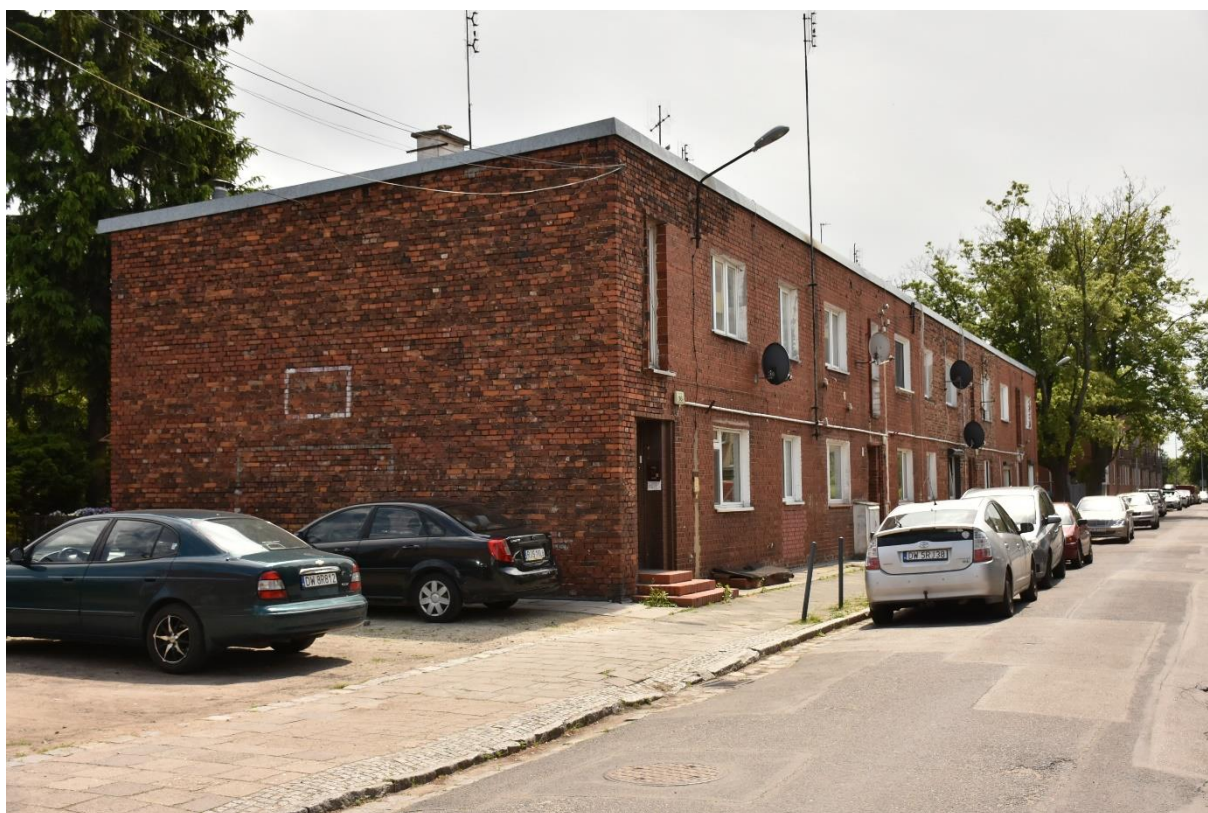
Fot. 18 Ulica Złotostocka. Ciąg budynków mieszkalnych nr 16, 18, 20, 22, widok od północnego zachodu.
