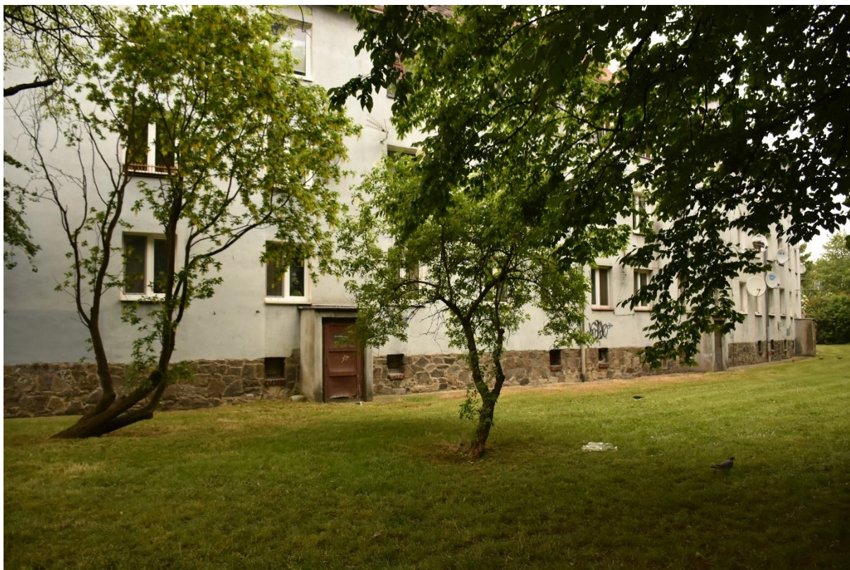
Fot. 67 Ulica Sernicka 34 - 40. Widok budynku od strony podwórka.
