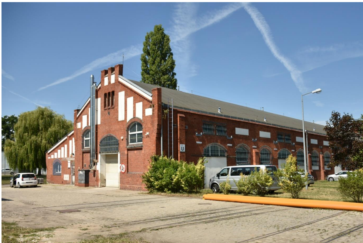
Fot. 55 Gazownia Miejska Wrocław-Tarnogaj, budynek dawnego magazynu, widok od południowego wschodu.
