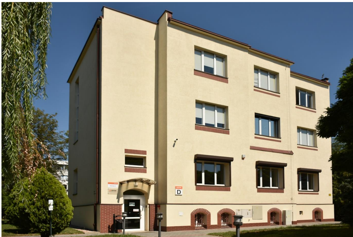
Fot. 45 Gazownia Miejska Wrocław-Tarnogaj, dawny budynek administracyjny, widok od południowego zachodu.
