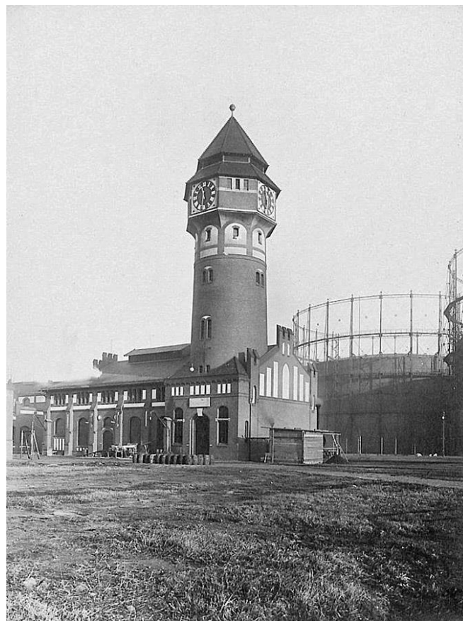
Fot. arch. 2 Zabudowania gazowni, widok na wieżę ciśnien i teleskopowe zbiorniki z gazem, 1922.
