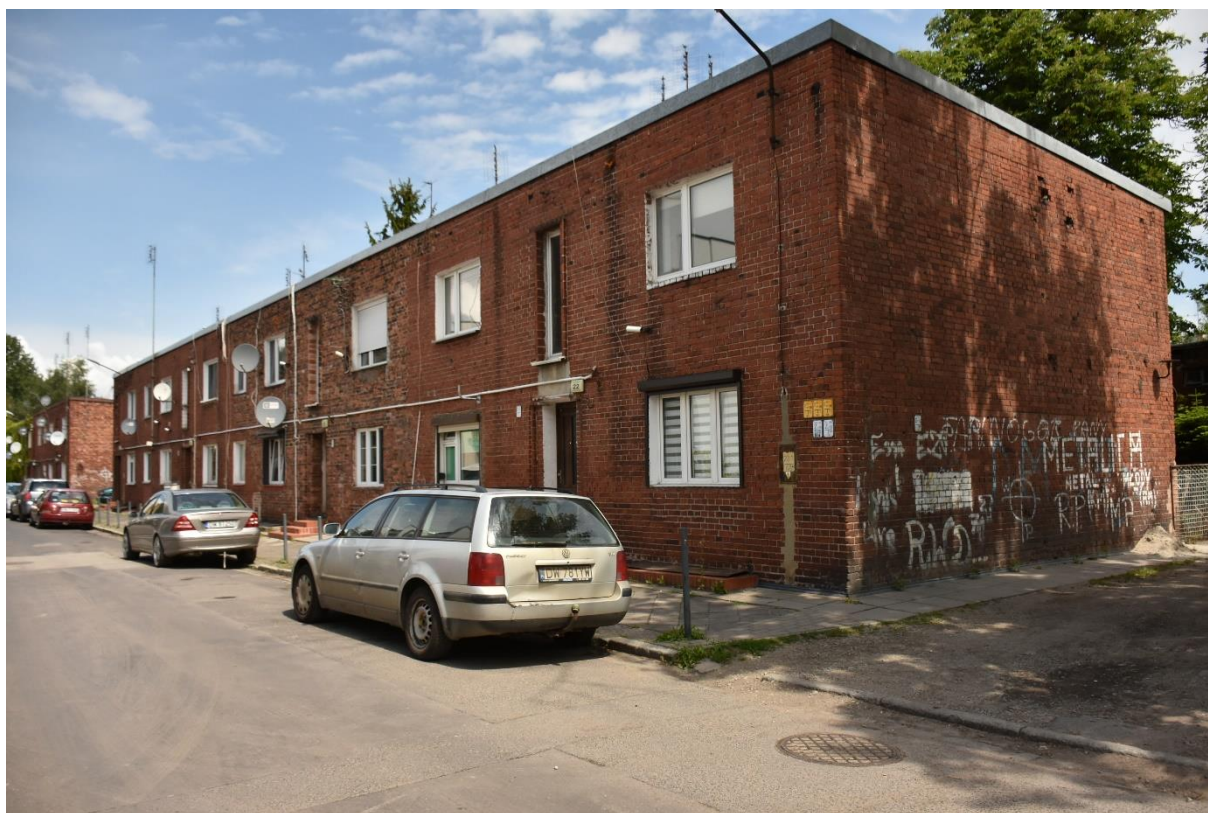
Fot. 20 Ulica Złotostocka. Ciąg budynków mieszkalnych nr 16, 18, 20, 22, widok od południowego zachodu.
