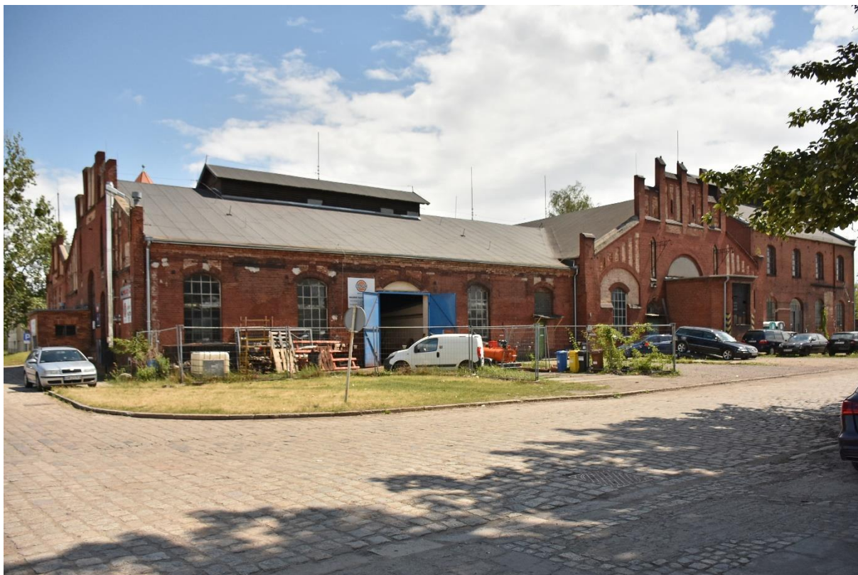
Fot. 29 Gazownia Miejska Wrocław-Tarnogaj, budynki dawnej kotłowni i maszynowni, widok od północnego zachodu.
