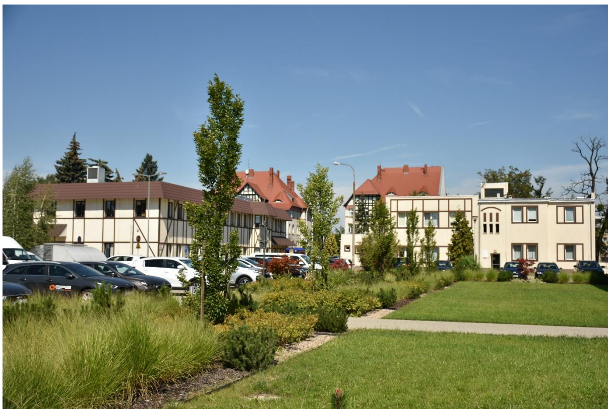
Fot. 48 Gazownia Miejska Wrocław-Tarnogaj, dawny warsztat I i laboratorium, widok od południa.
