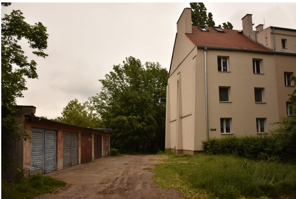
Fot. 84 Ulica Sernicka14, widok od zachodu.
