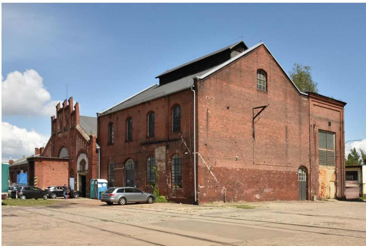
Fot. 32 Gazownia Miejska Wrocław-Tarnogaj, budynek dawnej kotłowni, widok od południowego zachodu.
