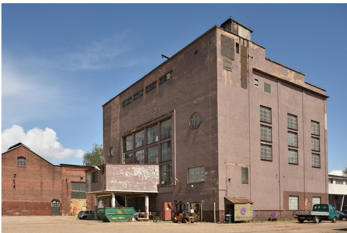
Fot. 36 Gazownia Miejska Wrocław-Tarnogaj, budynek nowej kotłowni z lat. 60. XX w., widok południowego zachodu.
