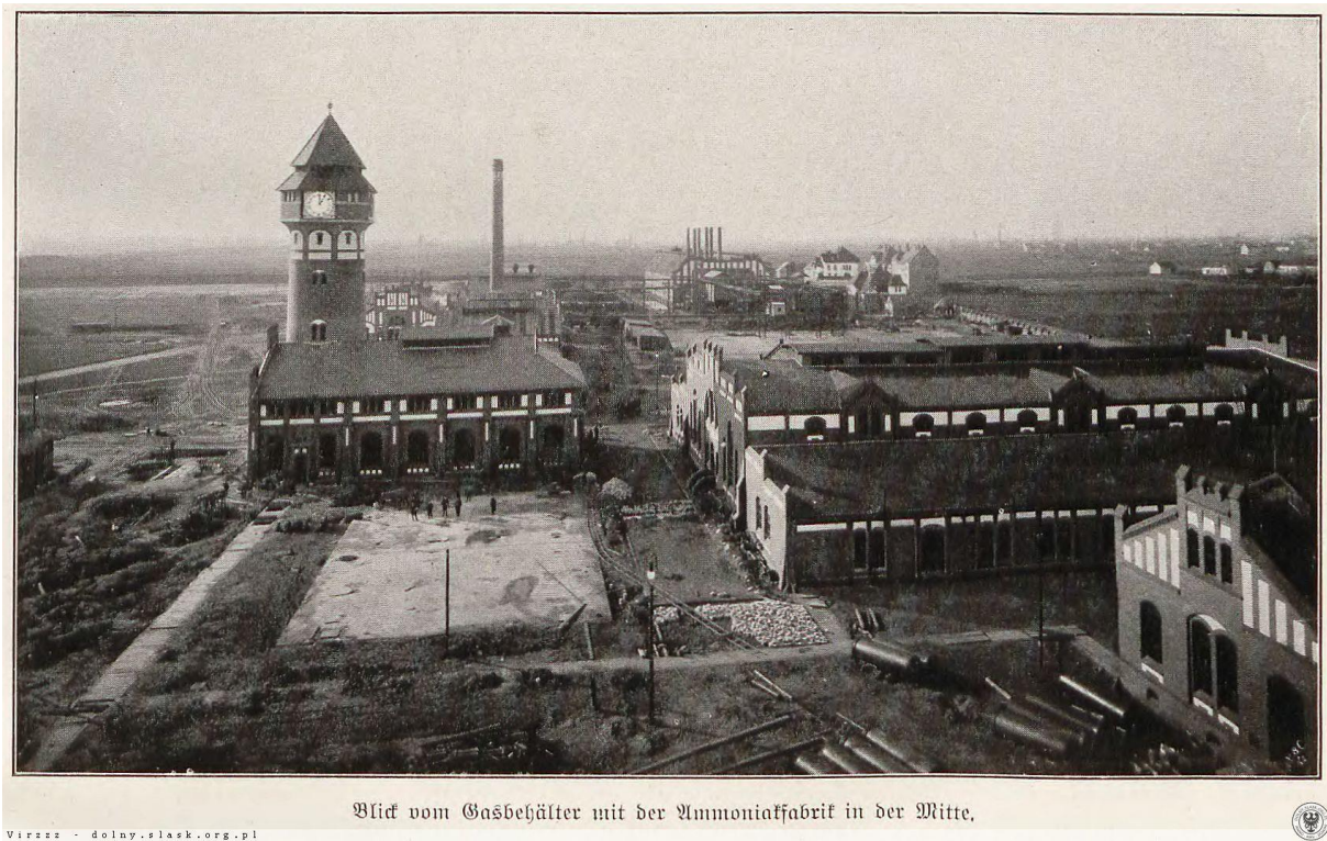
Fot. arch. 1 Zabudowania gazowni, widok od wschodu, ok. 1910-20.
