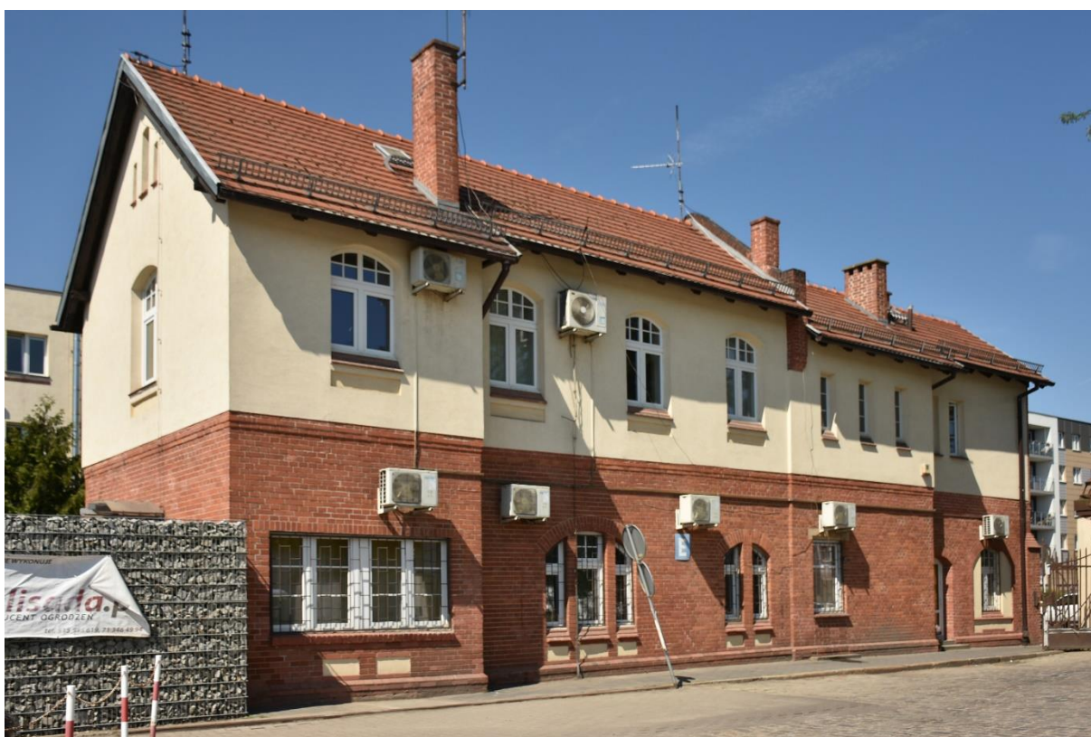
Fot. 42 Gazownia Miejska Wrocław-Tarnogaj, dawny budynek portierni i sprzedaży koksu, widok od północnego zachodu.
