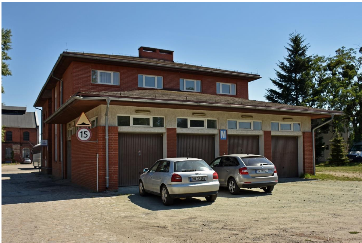
Fot. 61 Gazownia Miejska Wrocław-Tarnogaj, współczesny budynek stojący na zachód od dawnej kotłowni i maszynowni, widok od północnego zachodu.
