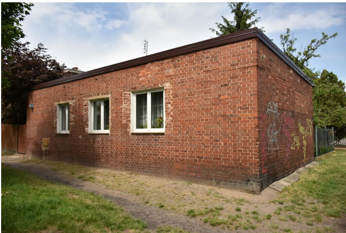
Fot. 14 Ulica Złotostocka. Łaźnia nr VII, widok od północnego wschodu.
