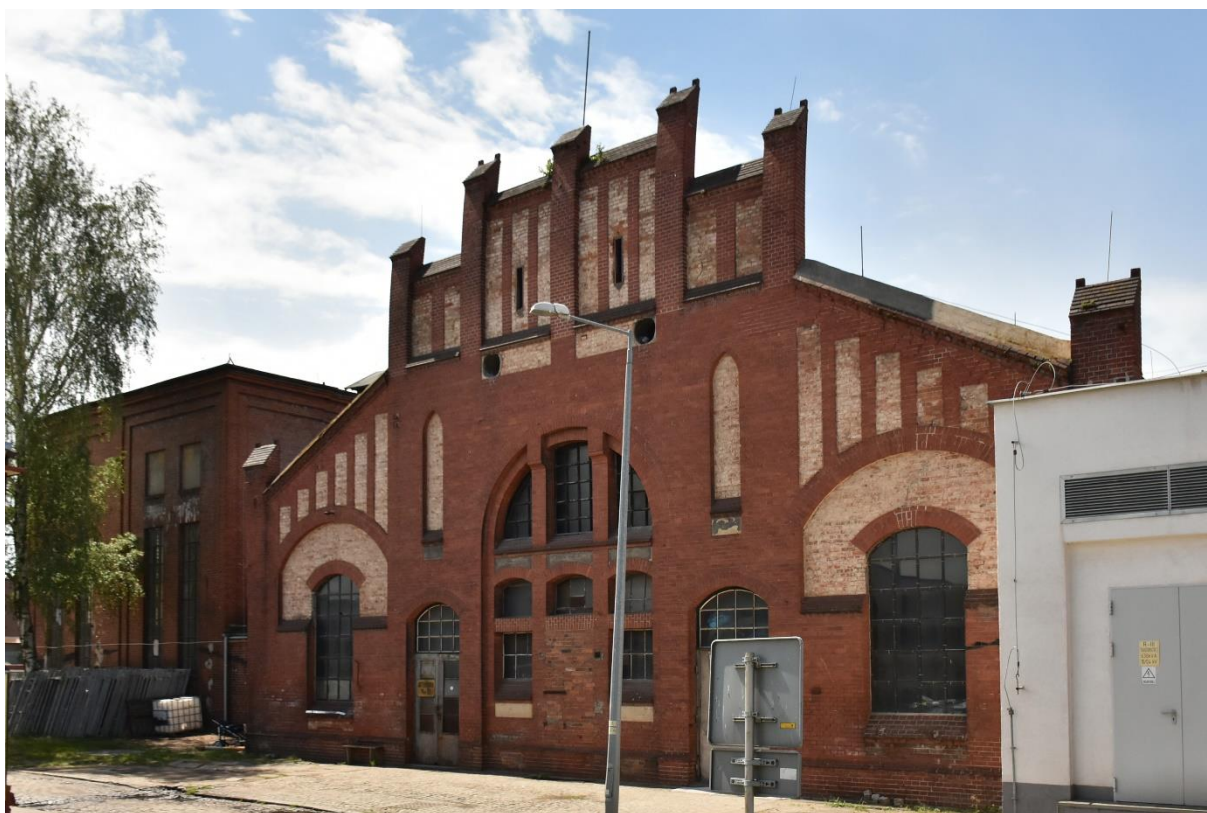
Fot. 30 Gazownia Miejska Wrocław-Tarnogaj, elewacja wschodnia budynku dawnej maszynowni.
