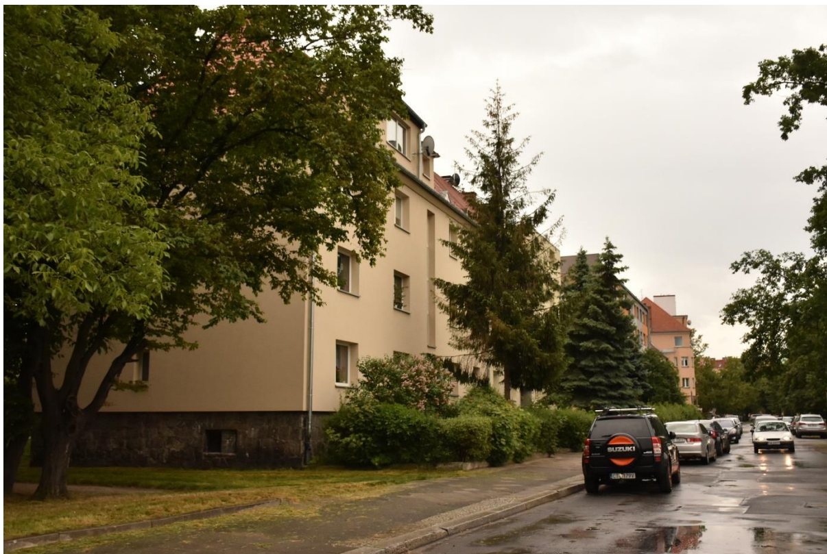
Fot. 65 Ulica Paczkowska 38. Widok od północnego zachodu w kierunku ulicy Jesionowej.
