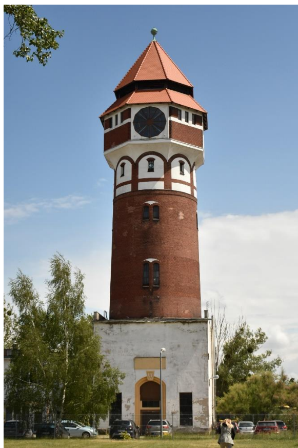
Fot. 34 Gazownia Miejska Wrocław-Tarnogaj, wieża wodna, widok od zachodu..
