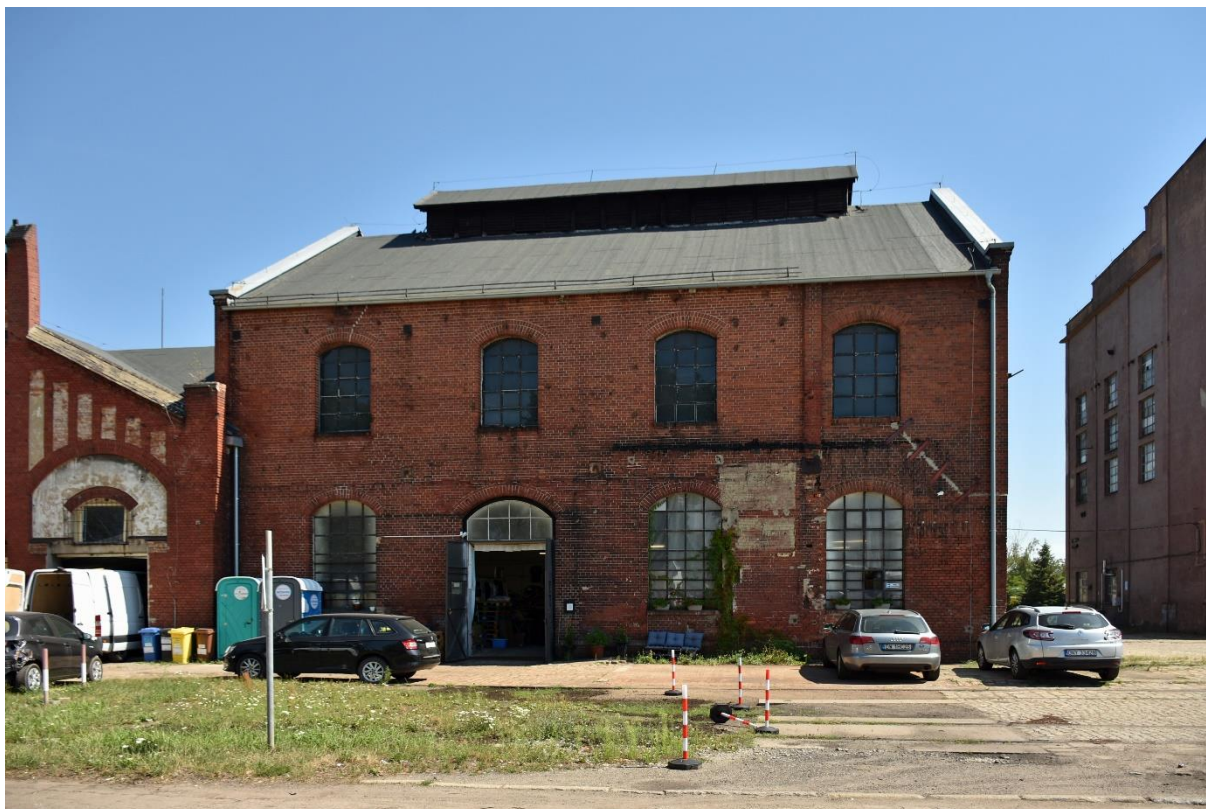
Fot. 33 Gazownia Miejska Wrocław-Tarnogaj, elewacja zachodnia budynku dawnej kotłowni.
