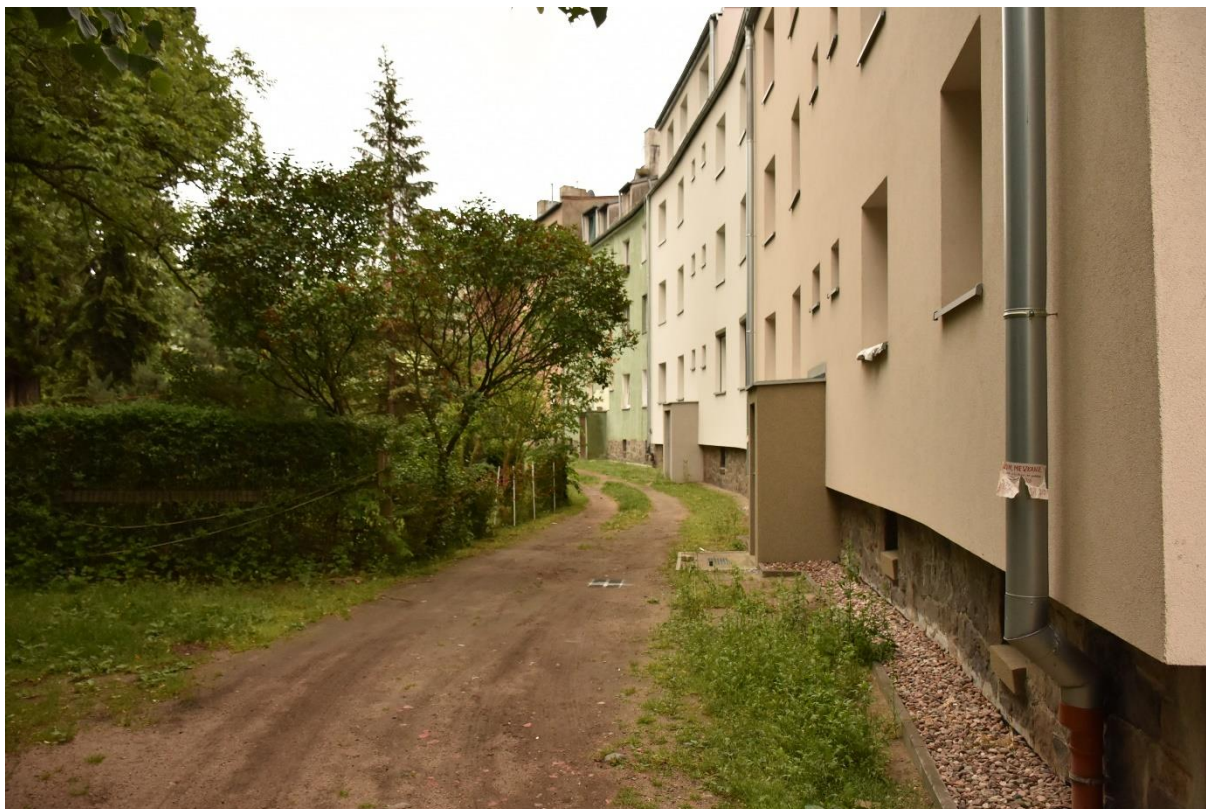
Fot. 86 Ulica Sernicka. Budynki nr 14-24, widok od strony podwórza.
