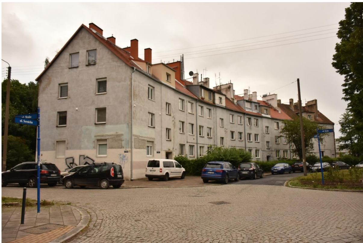
Fot. 87 Ulica Sernicka 34 - 40. Widok od strony ulicy Nyskiej.
