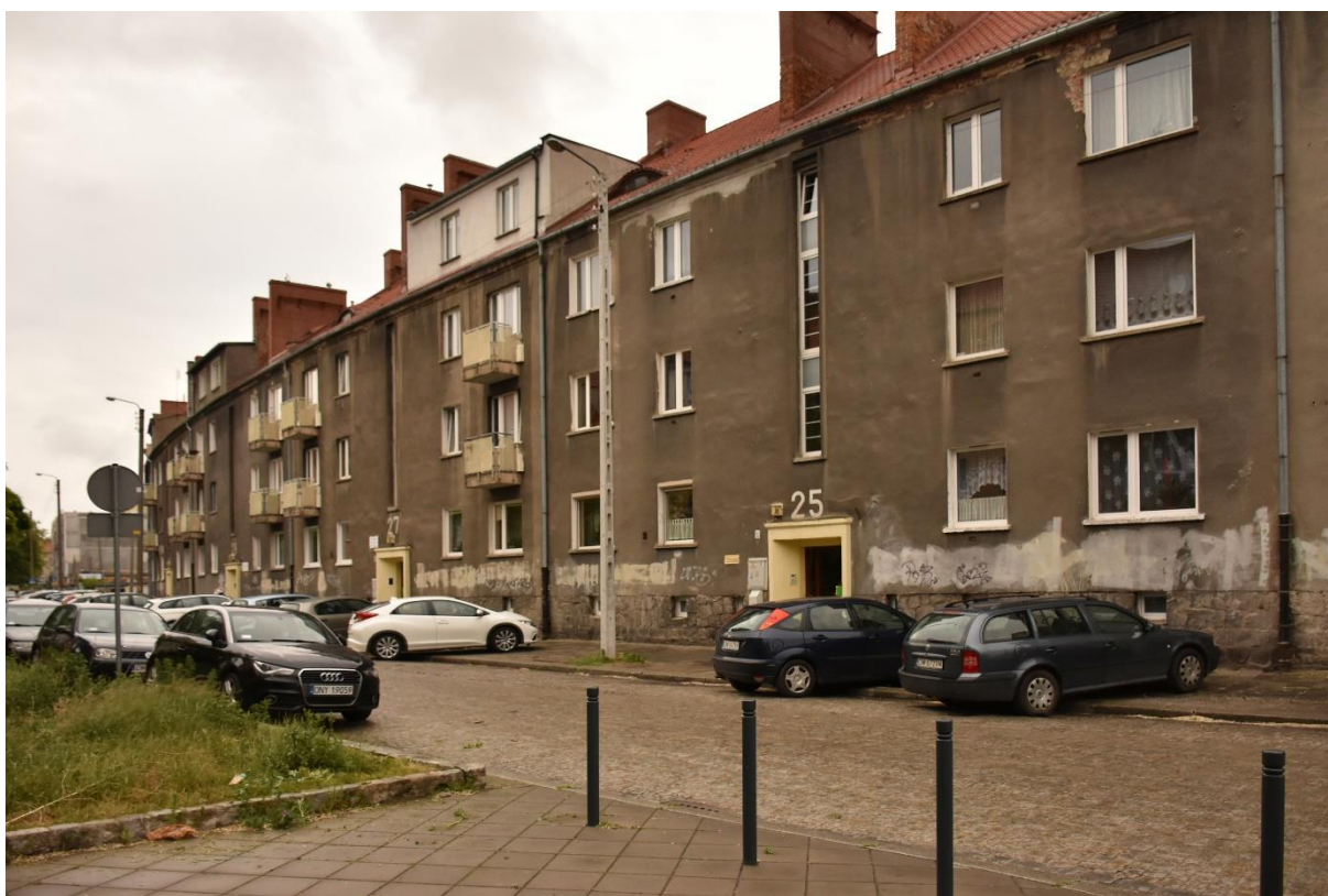
Fot. 76 Budynki przy ulicy Nyskiej nr 21 - 35. Widok kamienic od strony ulicy.
