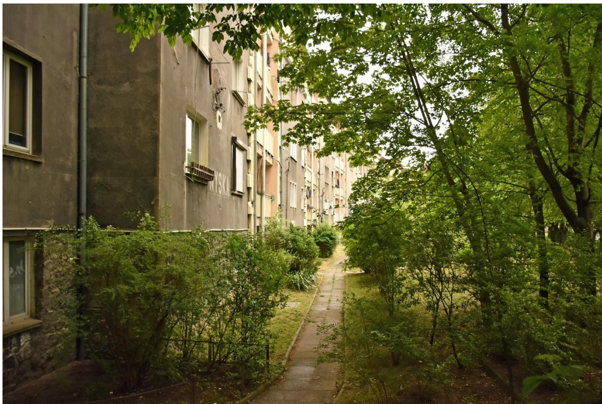
Fot. 71 Budynki przy ulicy Nyskiej nr 21 - 35. Widok budynku od strony podwórka.
