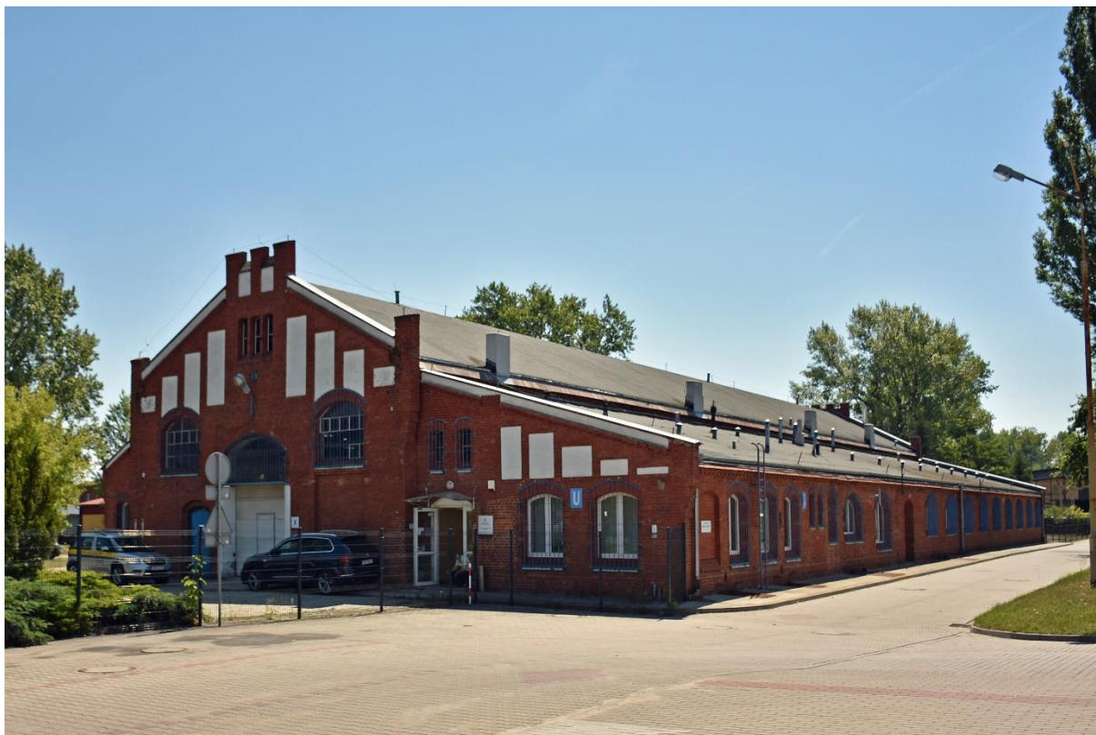
Fot. 53 Gazownia Miejska Wrocław-Tarnogaj, budynek dawnego magazynu, widok od północnego zachodu.
