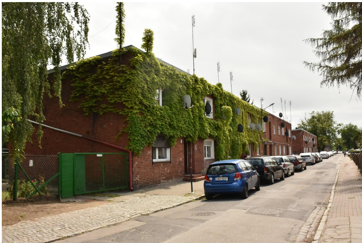
Fot. 15 Ulica Złotostocka. Ciąg budynków mieszkalnych nr 6, 8, 10, 12, widok od północy.
