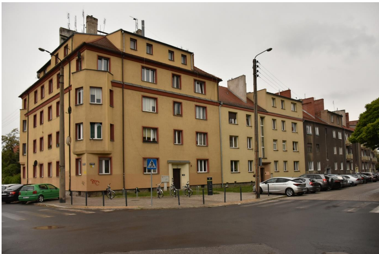
Fot. 91 Ulica Nyska. Budynek nr 37 z charakterystycznym narożem, widok od wschodu.
