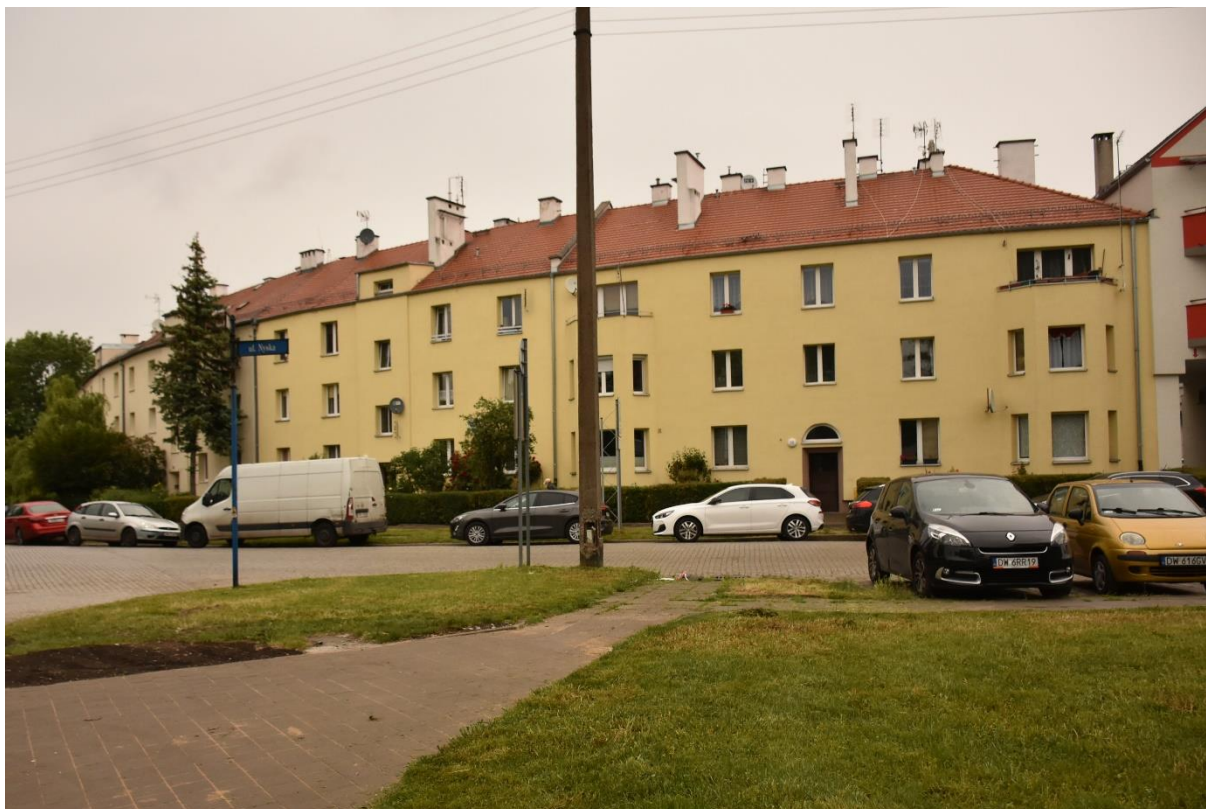
Fot. 63 Ulica Nyska, bud. Nr 16 z charakterystycznymi wykuszami, widok od południowego zachodu.
