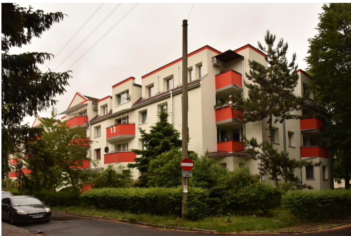
Fot. 82 Ulica Sernicka, budynek nr 13.
