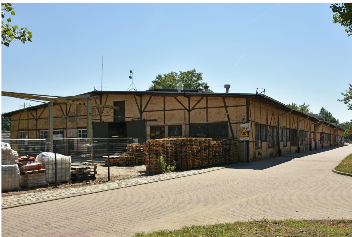
Fot. 56 Gazownia Miejska Wrocław-Tarnogaj, budynek dawnego warsztatu nr II, widok od północnego zachodu.
