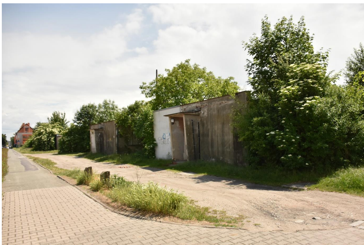
Fot. 26 Ulica Klimasa. Widok w kierunku ul. Tarnogajskiej z widocznymi opuszczonymi prowizorycznymi budynkami mieszkalnymi.
