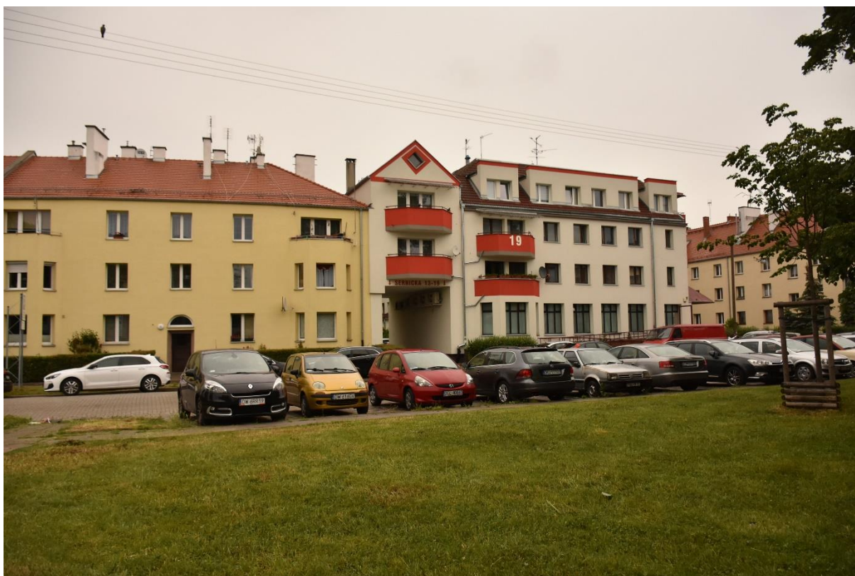
Fot. 64 Ulica Nyska, bud. Nr 16 oraz nowy budynek znajdujący się przy ulicy Sernickiej nr 13-19, widok od południowego zachodu.
