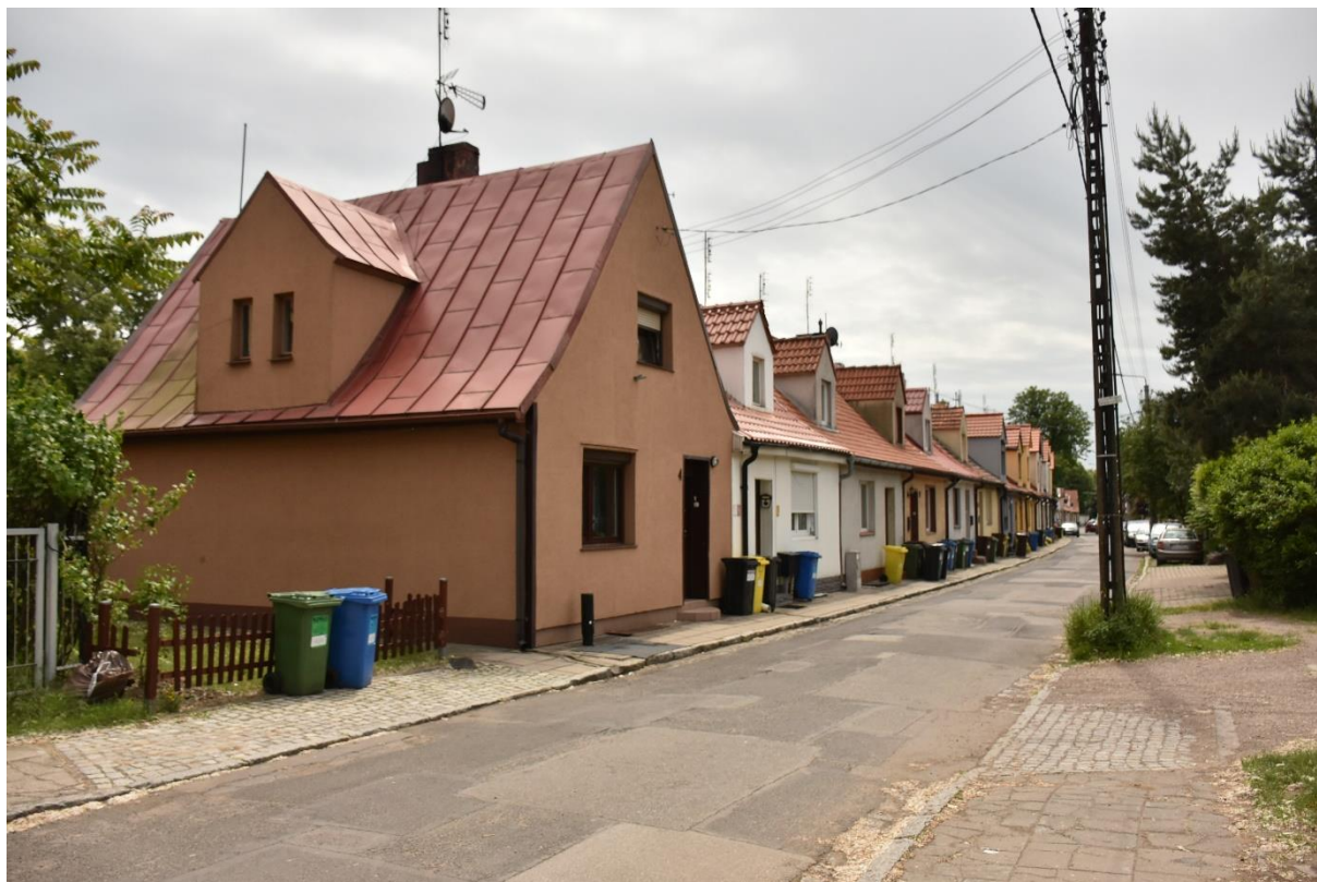
Fot. 7 Ulica Kamieniecka. Zabudowa szeregową domów jednorodzinnych, widok od północy.
