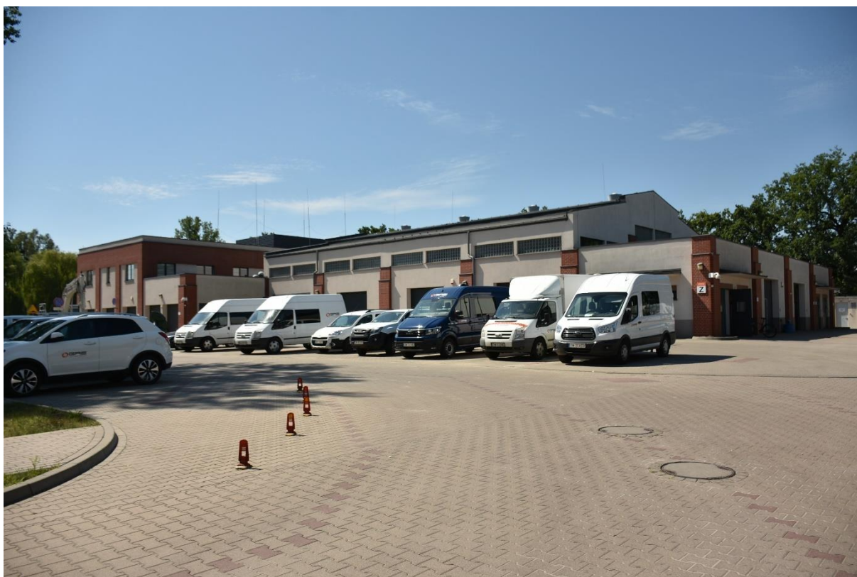
Fot. 52 Gazownia Miejska Wrocław-Tarnogaj, współczesny budynek w zachodniej części obszaru, widok od północnego wschodu.
