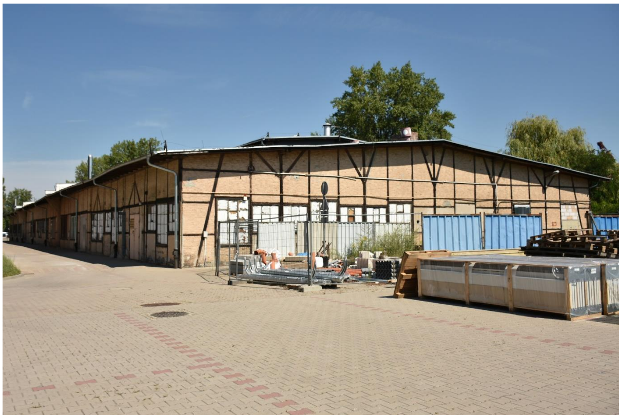
Fot. 57 Gazownia Miejska Wrocław-Tarnogaj, budynek dawnego warsztatu nr II, widok od południowego zachodu.
