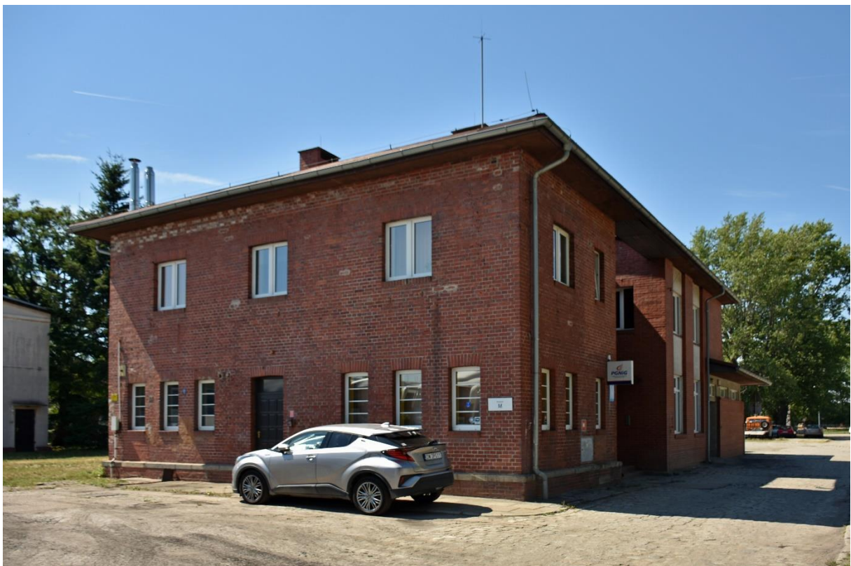
Fot. 60 Gazownia Miejska Wrocław-Tarnogaj, współczesny budynek stojący na zachód od dawnej kotłowni i maszynowni, widok od północnego wschodu.
