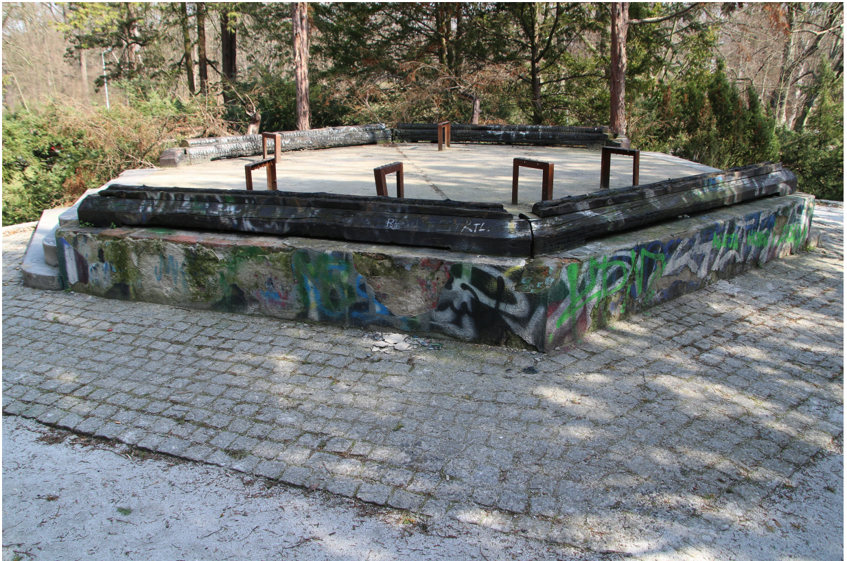
fot.1 – Widok cokołu od strony południowej.
