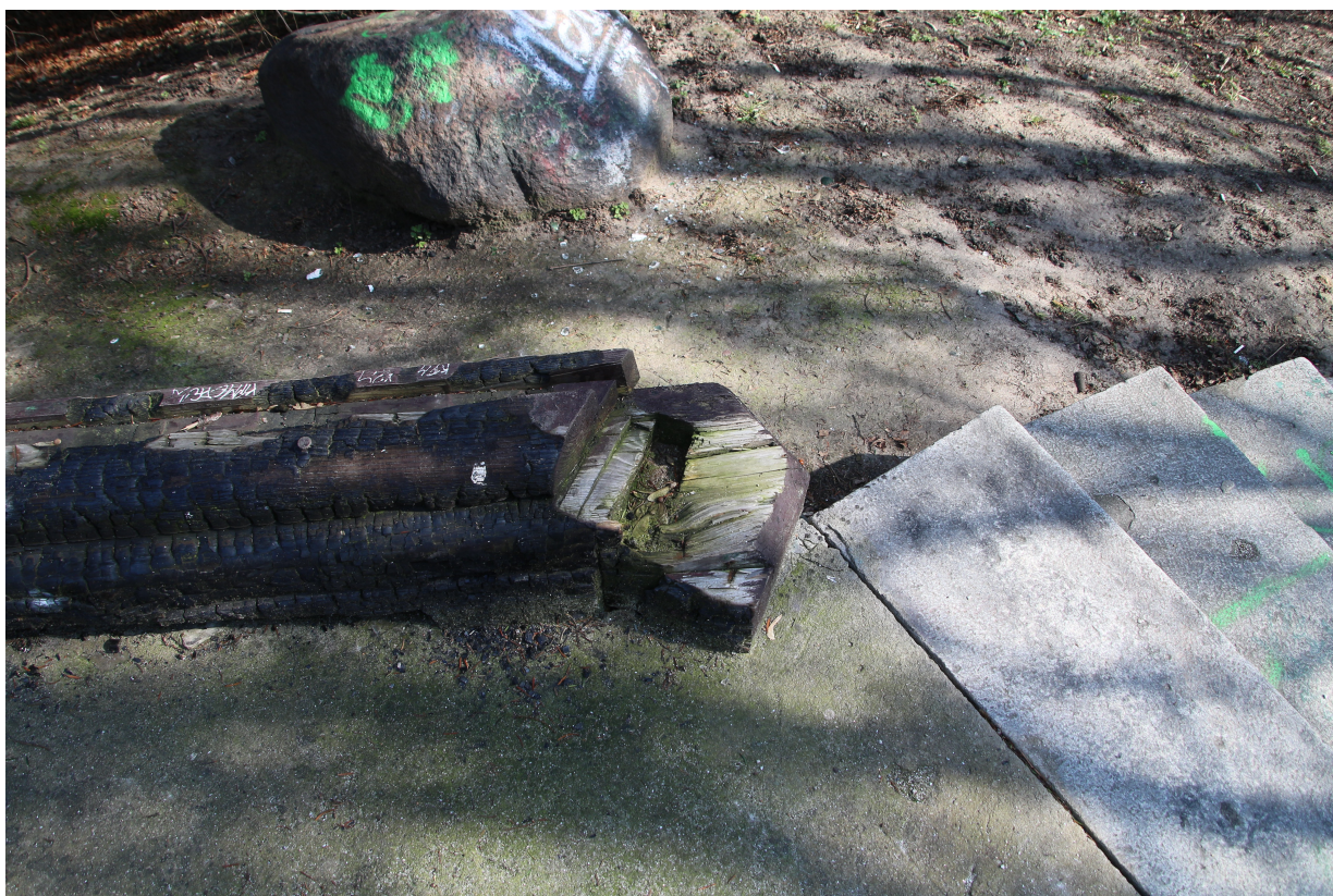
fot.4 – Uszkodzenia zachowanej podwaliny.
