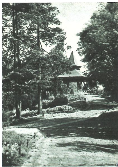
Altana odremontowana – fot. z lat 60-tych XXW.
