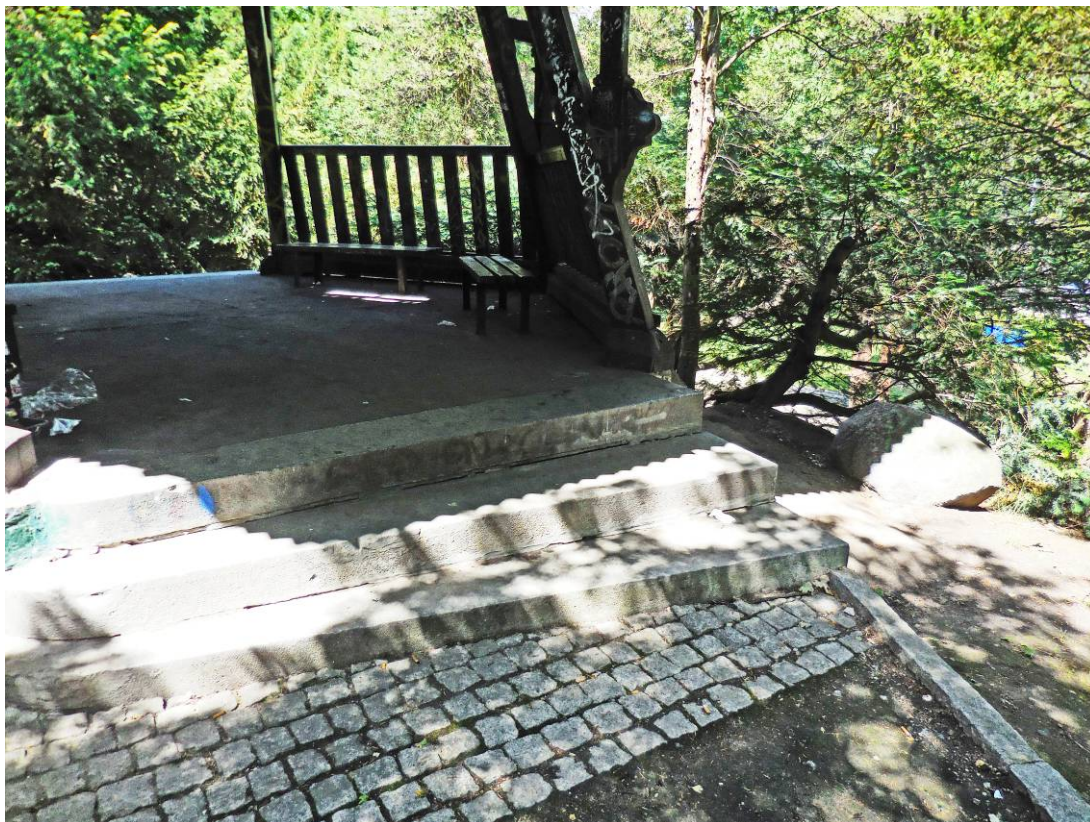
Zdjęcie Nr 4 Schody.
