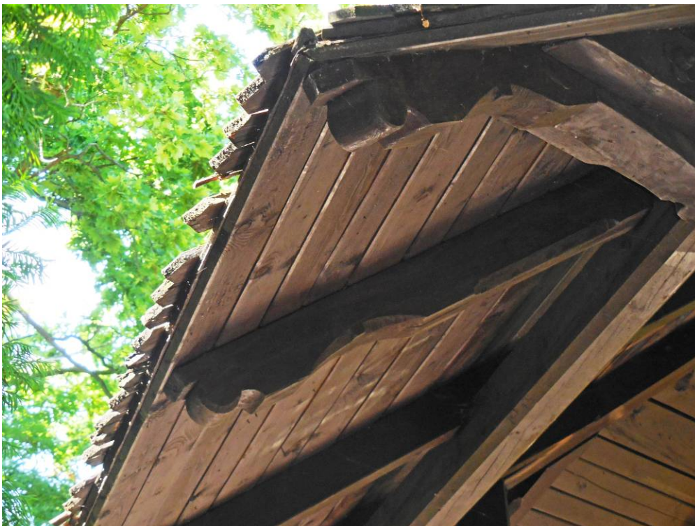
Zdjęcie Nr 5 Elementy pokrycia.
