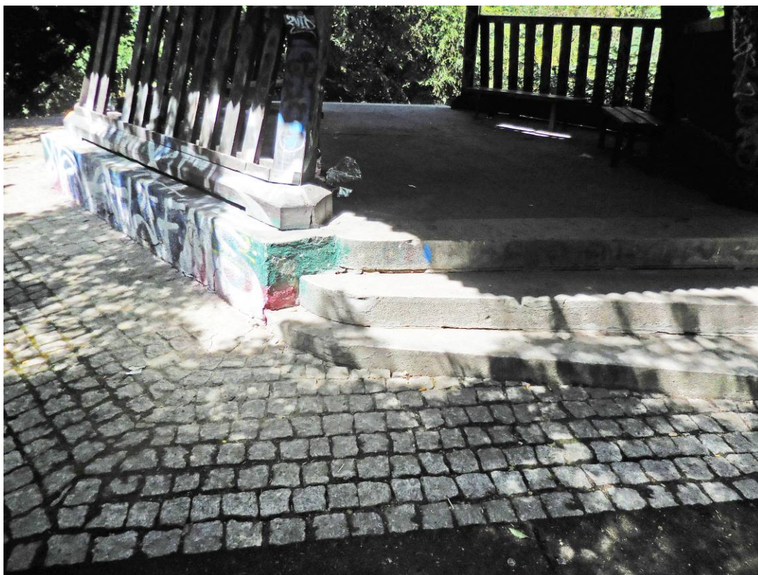
Zdjęcie Nr 3 Schody.
