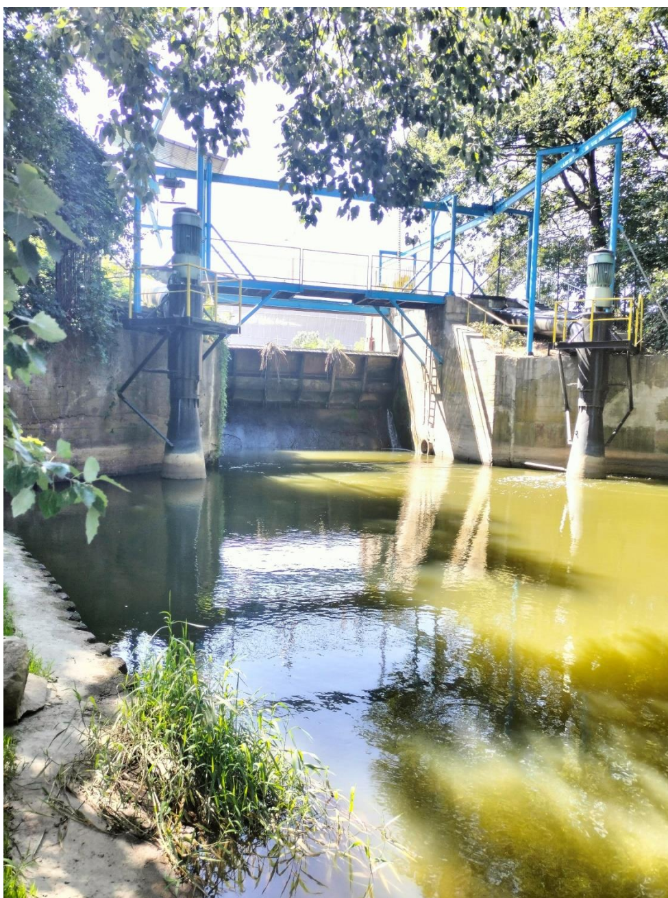
Fot-Icht 3. Tama i elektrownia na Ślęzy w Maślicach (fot. J. KOTUSZ).
