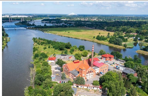
Fot. 2 Przepompownia – Stary Port (fot. K. Szeremeta, DGBiTR we Wrocławiu)
