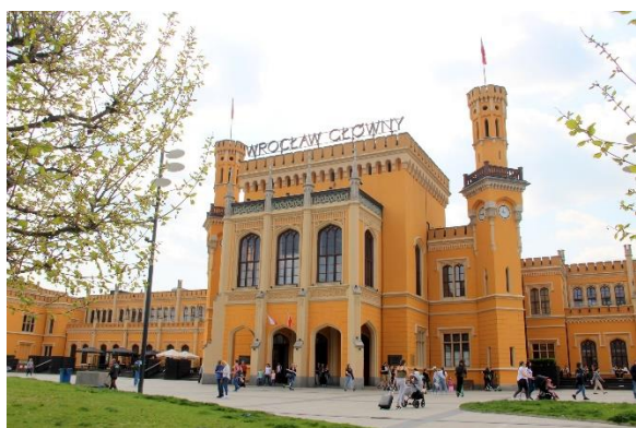
Fot. 1 Widok na budynek Głównego Dworca Kolejowego i plac przed wejściem do budynku (fot. M. Wołowiec, IRT)
