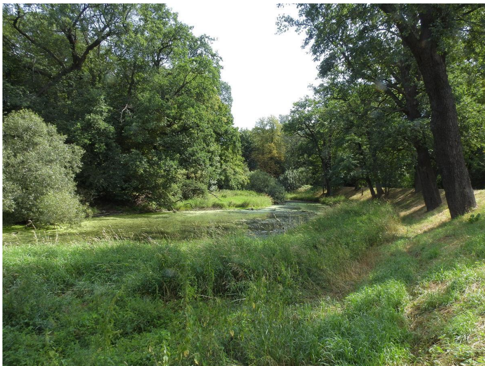
Fot. 2. Środkowa część zbiornika 2, widoczny wykasany wał przeciwpowodziowy i zasypane podstawy pni dębów (07.2022, fot. E. Szczęśniak).
