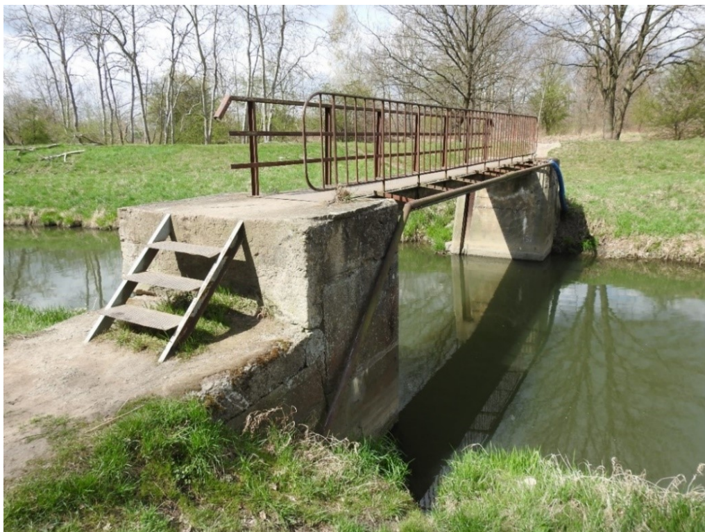
Fot-Por-1. Kładka nad Ślężą – stanowisko porostów naskalnych. (fot. M. Kossowska).
