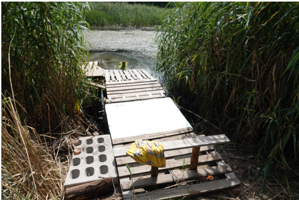
Fot. 27. Pomost na zbiorniku północnym.
