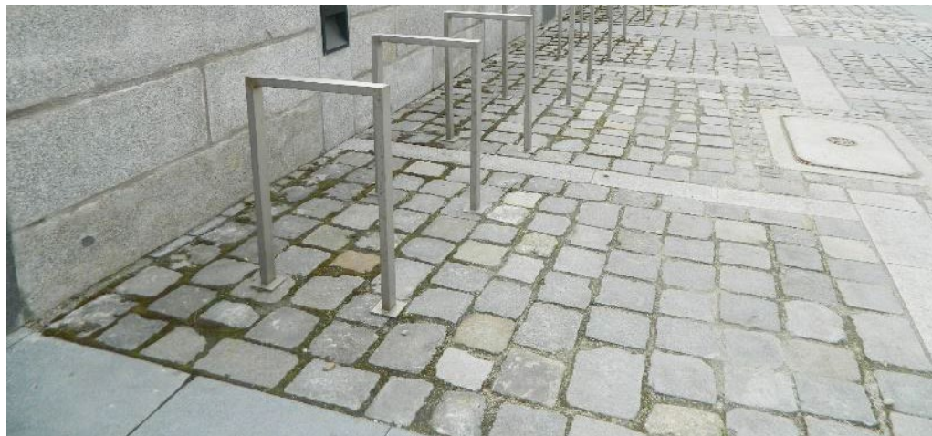
Parking na rowery, dworzec PKP, Wrocław (fot. E. Burszta-Adamiak)
