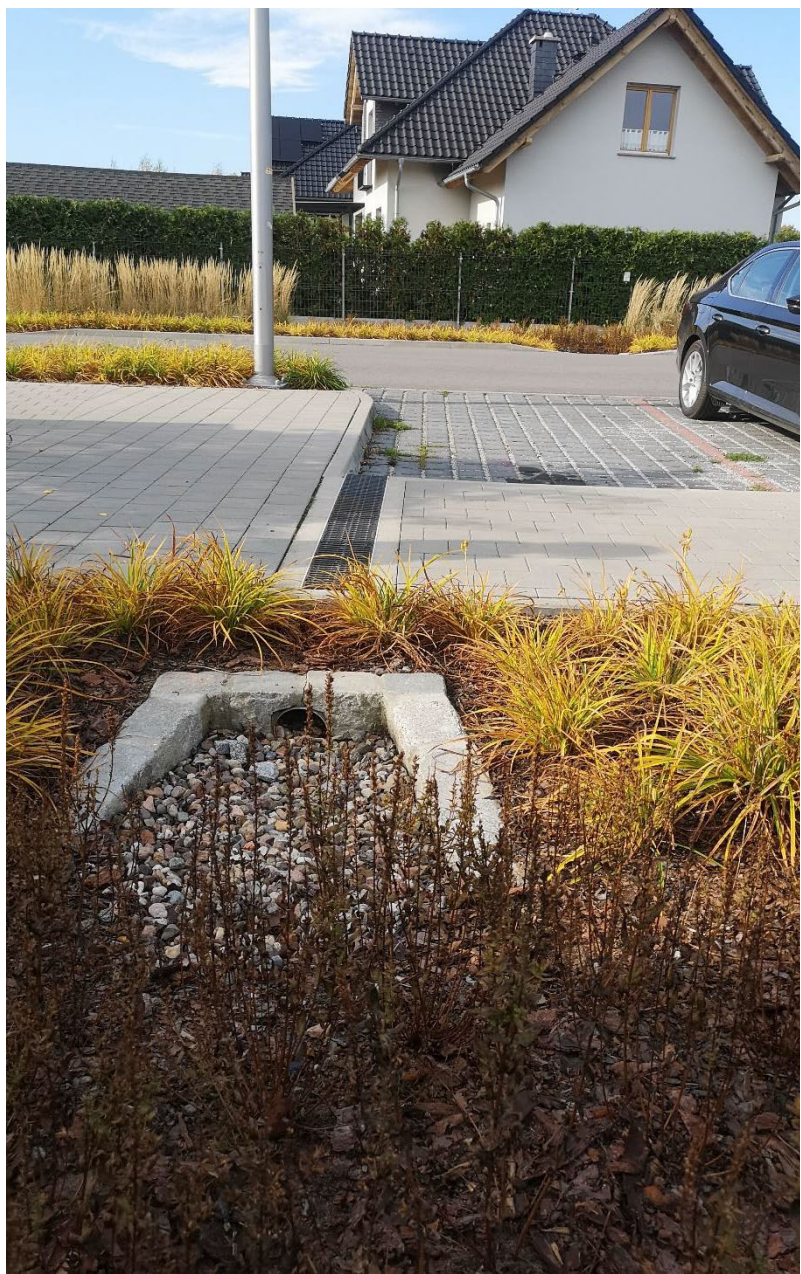
Odprowadzenie wód z parkingu do muldy (fot. UM Wrocław)
