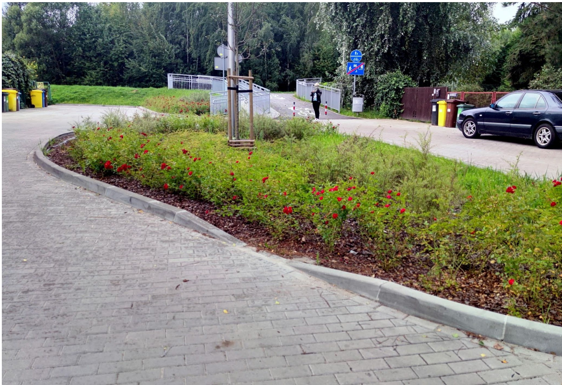
Wypustka uliczna (fot. UM Wrocław)
