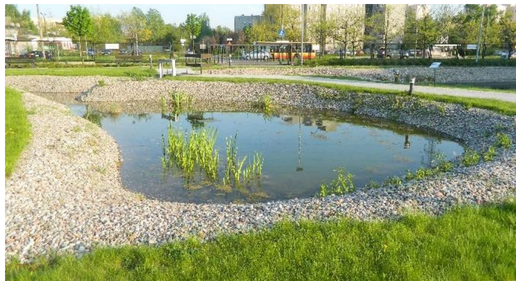
Stanowiska pilotowe stawów hydrofitowych w Centrum Wodnym SGGW, Warszawa (fot. E. Burszta-Adamiak)
