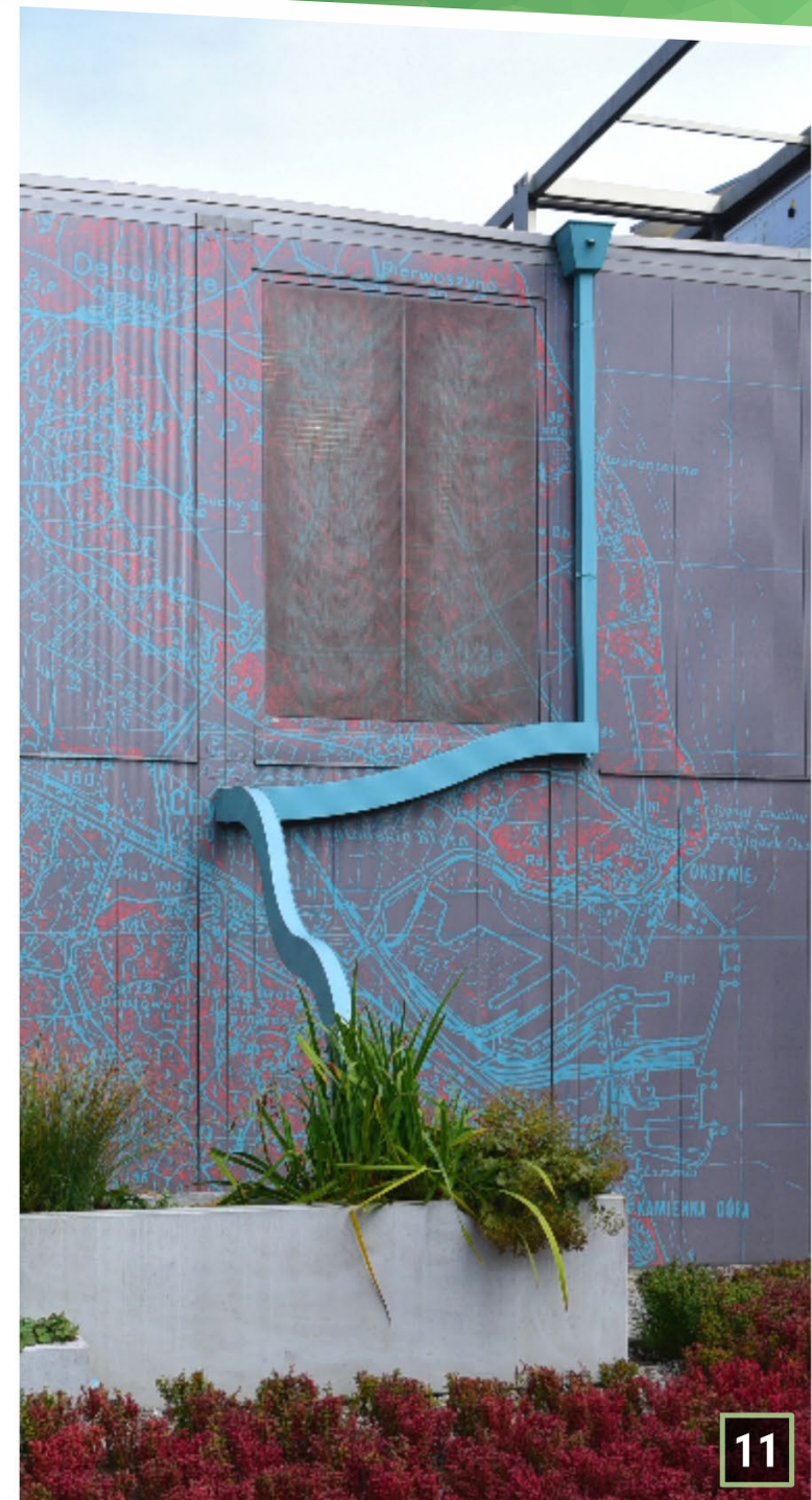
13 Fot. 11-13. Ogród deszczowy w pojemniku, budynek InfoBoxu w Gdyni (Gdynia, M. Śpitalniak)
