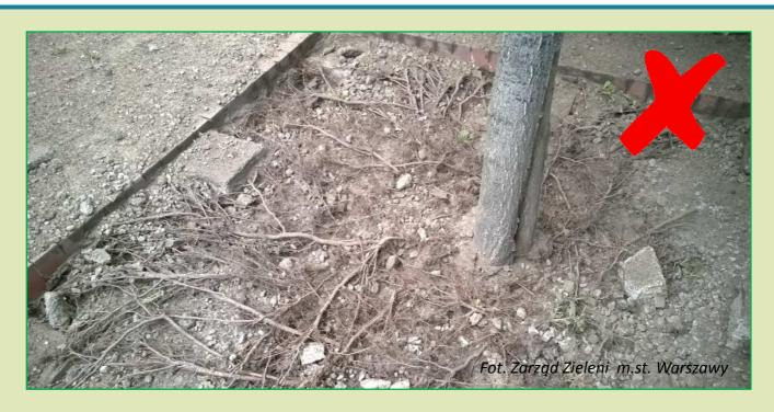
Odsłonięte korzenie drzew należy zabezpieczyć przed przesychaniem, a ściany wykopu w SOD przed osunięciem.
