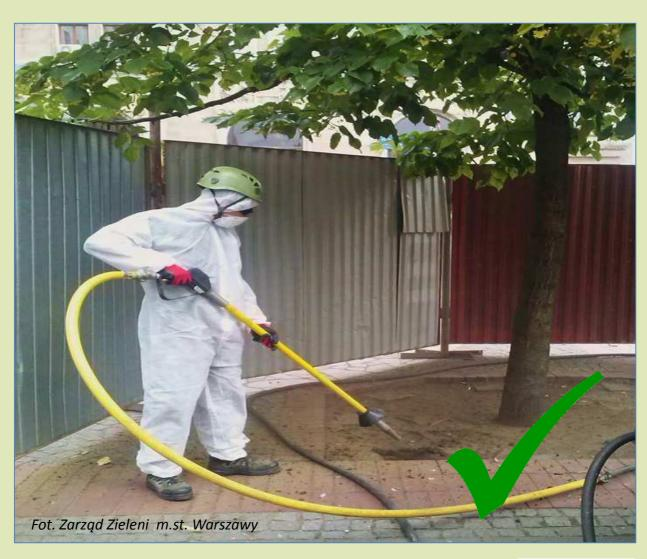
Należy zabezpieczyć korzenie w strefie ochrony drzew (SOD) podczas prac rozbiórkowych, korytowania pod nawierzchnie i wykopów pod budynki.
