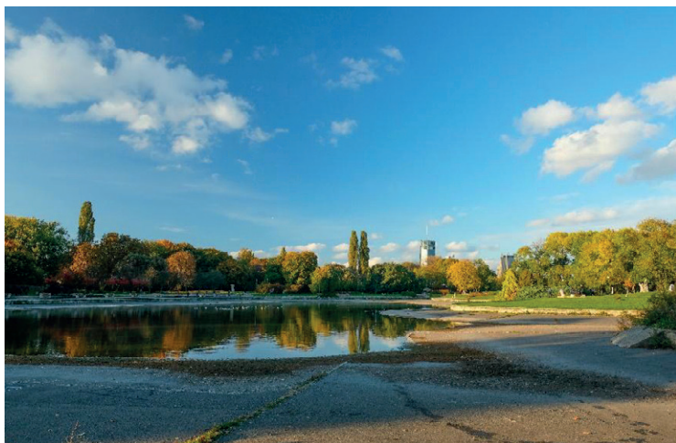
Rys. 6.1. Pole Mokotowskie w Warszawie. Zbiornik wodny z uszczelnionym betonowym dnem, z którego woda jest spuszczana na zimę, został przeprojektowany i będzie zrealizowany, jako że starsze rozwiązanie generowało ogromne koszty i nie przynosiło korzyści środowiskowych (fot. P. Sikorski)
