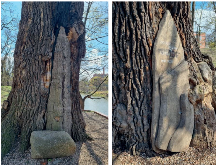
Rys. 6.49. Przykłady zabezpieczenia ubytków otwartych w cennych drzewach, zapewniających ochronę przed podpaleniem i zaśmiecaniem, Wrocław (fot. B. Pachnowska)
