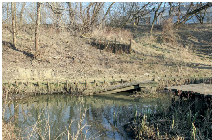
Rys. 6.19. Umocnienie palisadą drewnianą grobli biofiltra w Porcie Czerniakowskim w Warszawie, kładka/pochylnia umożliwia korzystanie z wody i lądu ptakom i płazom (fot. S. Sendzielski)
