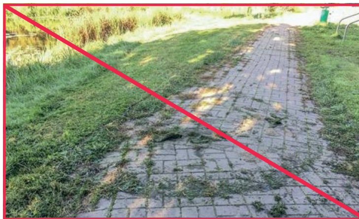
Rys. 3.10. Działania niezgodne ze standardem – podczas koszenia ciągów komunikacyjne na bieżąco należy oczyszczać z pokosu (fot. S. Sendzielski)
