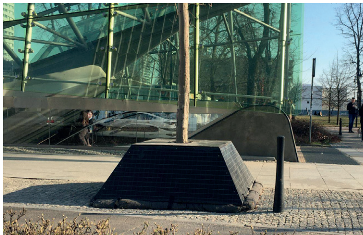
Rys. 1.11. Zimowe zabezpieczenie mis drzew w ciągu pieszym w Warszawie (fot. S. Sendzielski)
