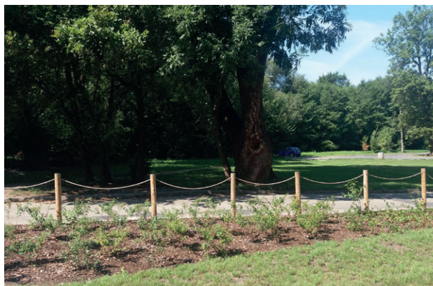
Rys. 1.5. Słupki drewniane połączone liną (fot. ZZM Kraków)
