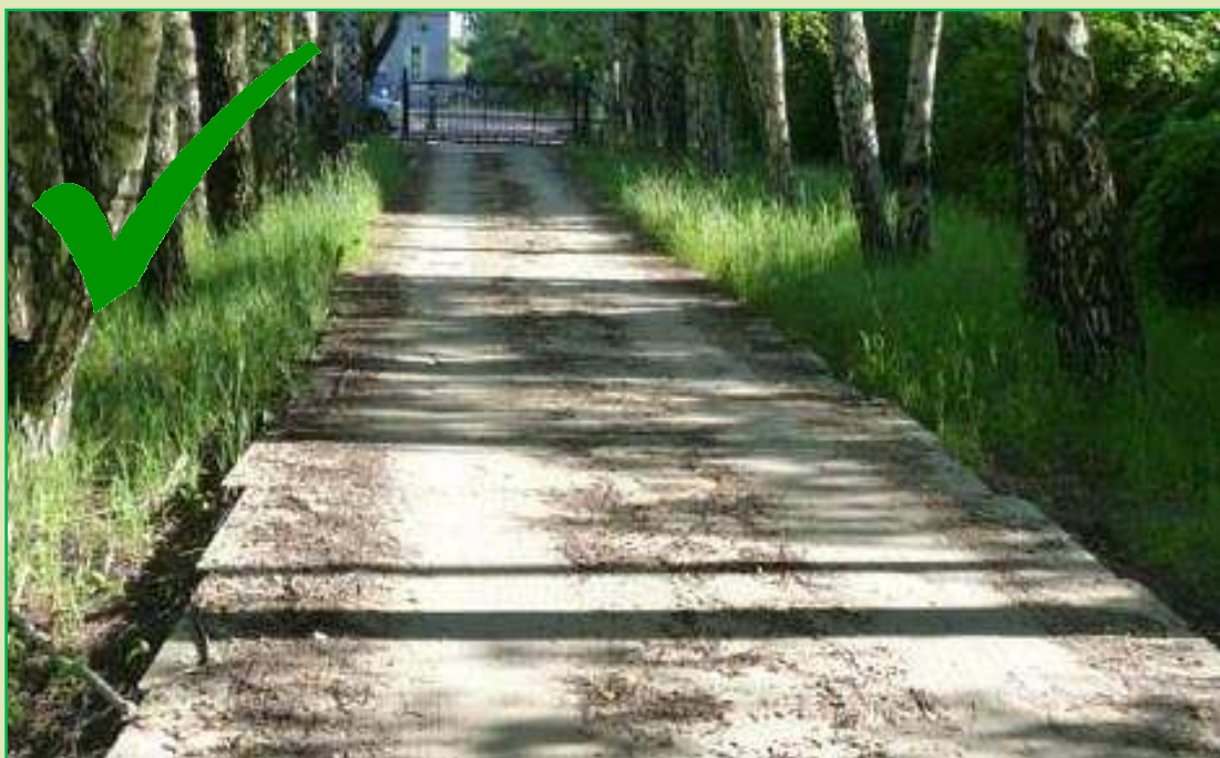
Technologiczna droga tymczasowa z płyt betonowych ułożonych na warstwie żwiru
