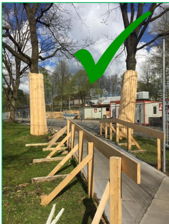
Poruszanie się po tymczasowych drogach technologicznych w SOD
