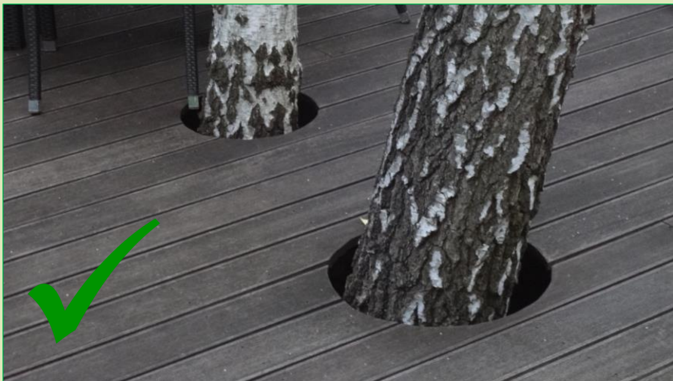
Nawierzchnie wykonane na punktowych fundamentach
