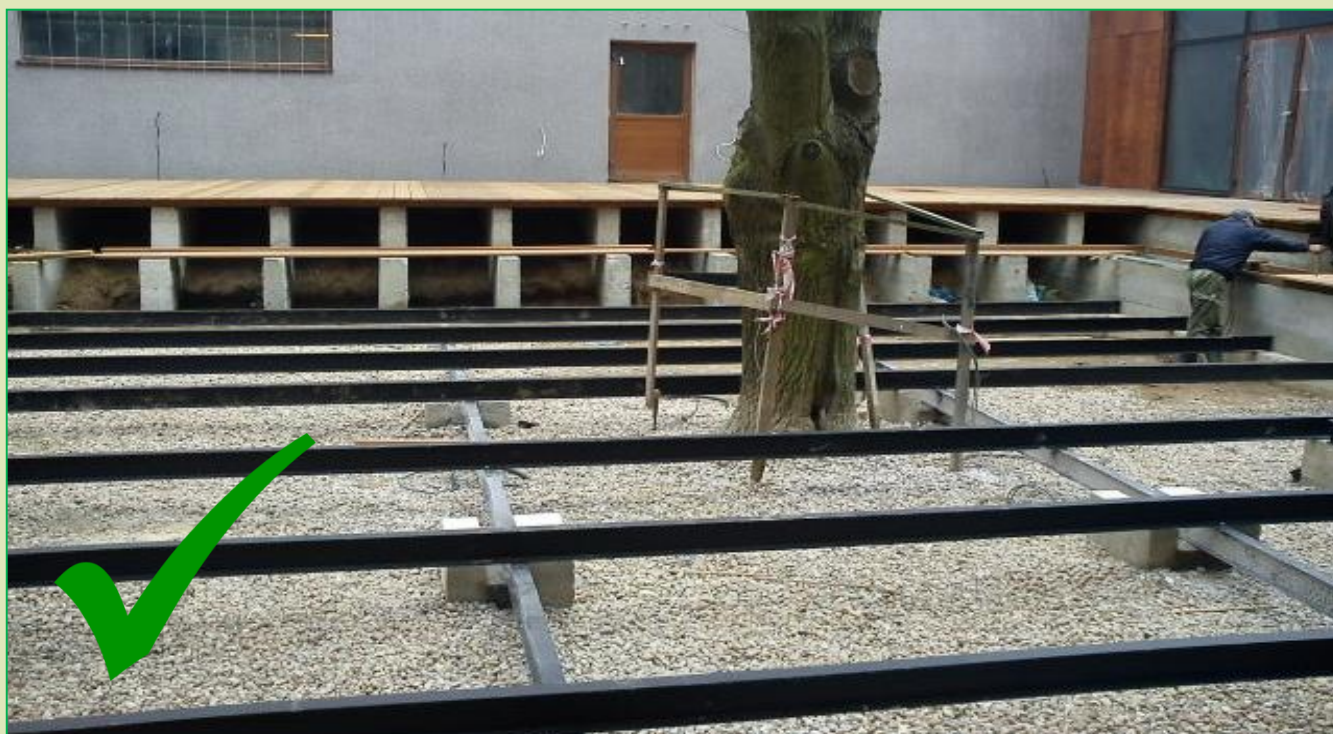
Nawierzchnia drewniana wykonana na punktowych fundamentach
