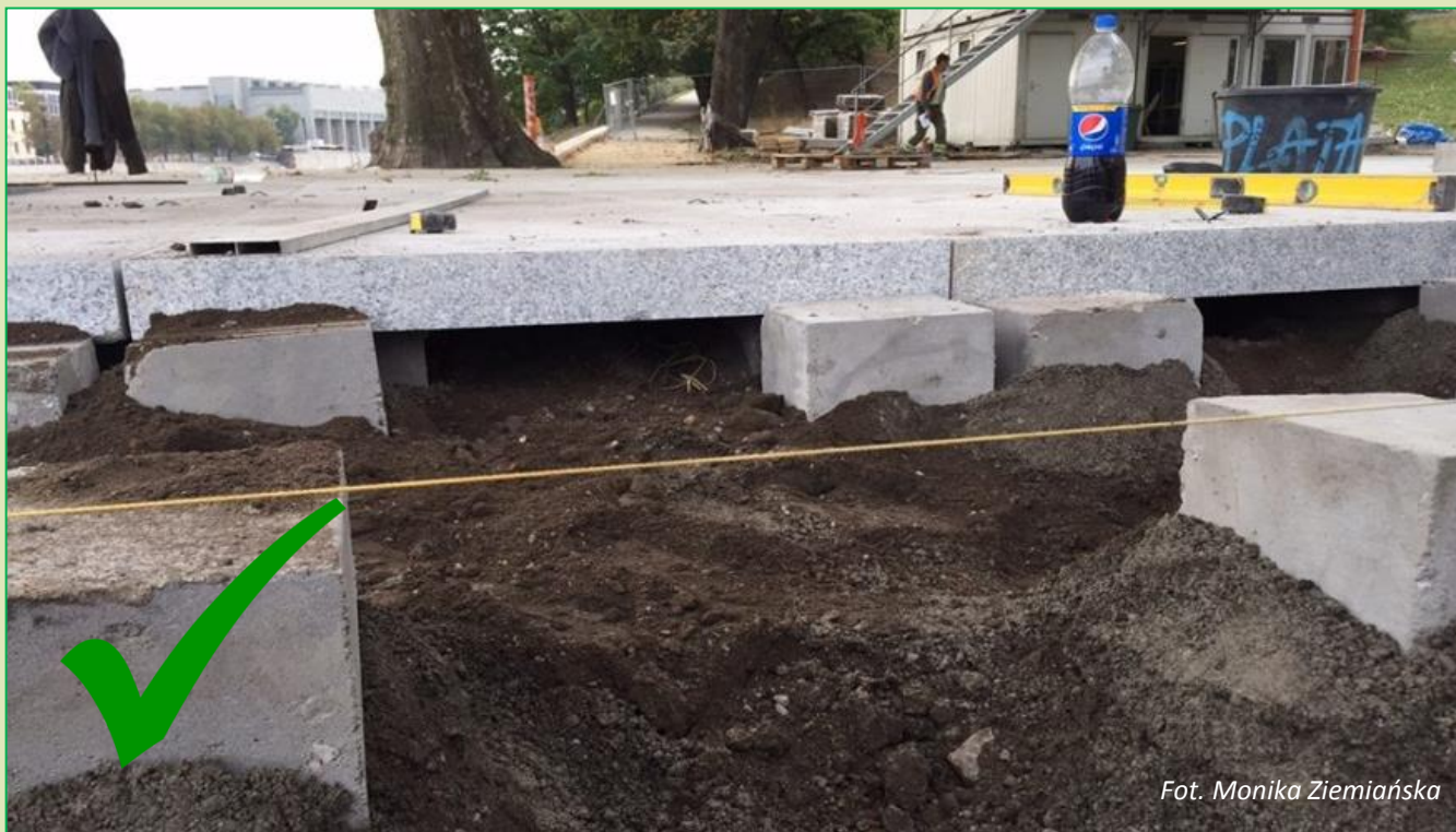
Nawierzchnie wykonane na punktowych fundamentach
